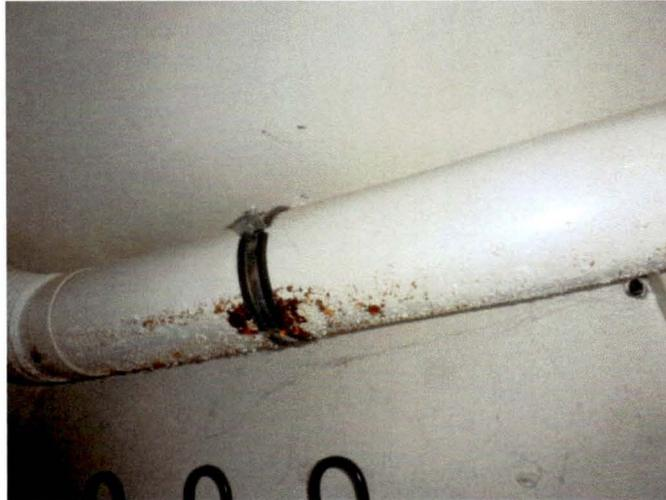
**Korrosion Abgasrohr Heizung**
