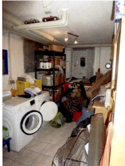
Heizung/Waschraum im KG
