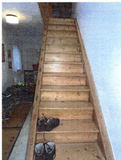
Flur mit Treppe zum DG
