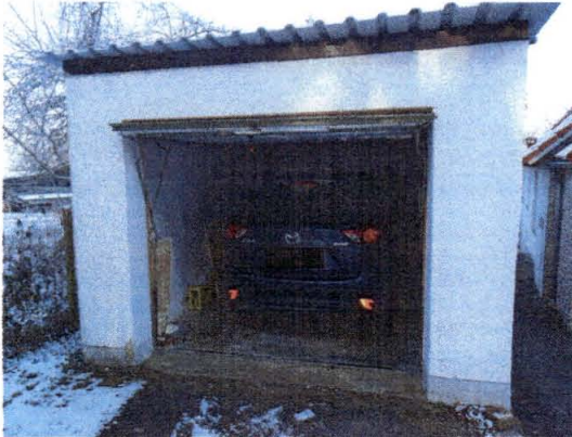
Südostseite der Garage
