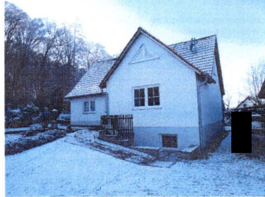
Ostseite des Gebäudes
