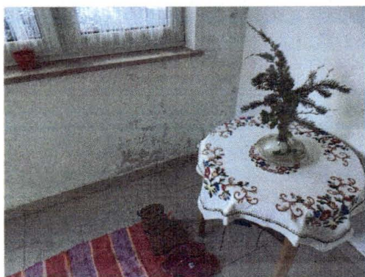
Feuchtigkeitsschäden Eingangsbereich
