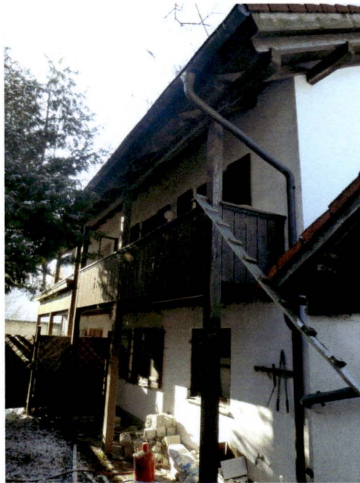
Blick von Nordosten auf das Wohngebäude
