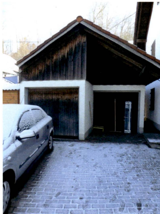
Blick von Westen auf das Nebengebäude
