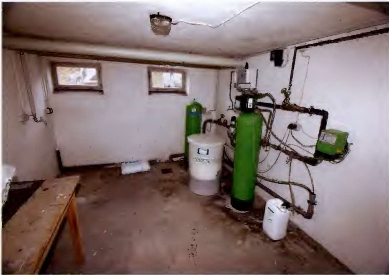
Technikraum UG mit Wasserenthärtung
