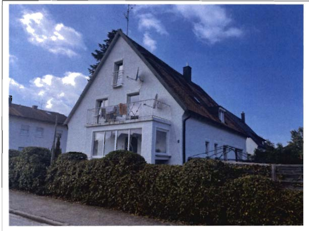
Foto 1: Ansicht von Osten
