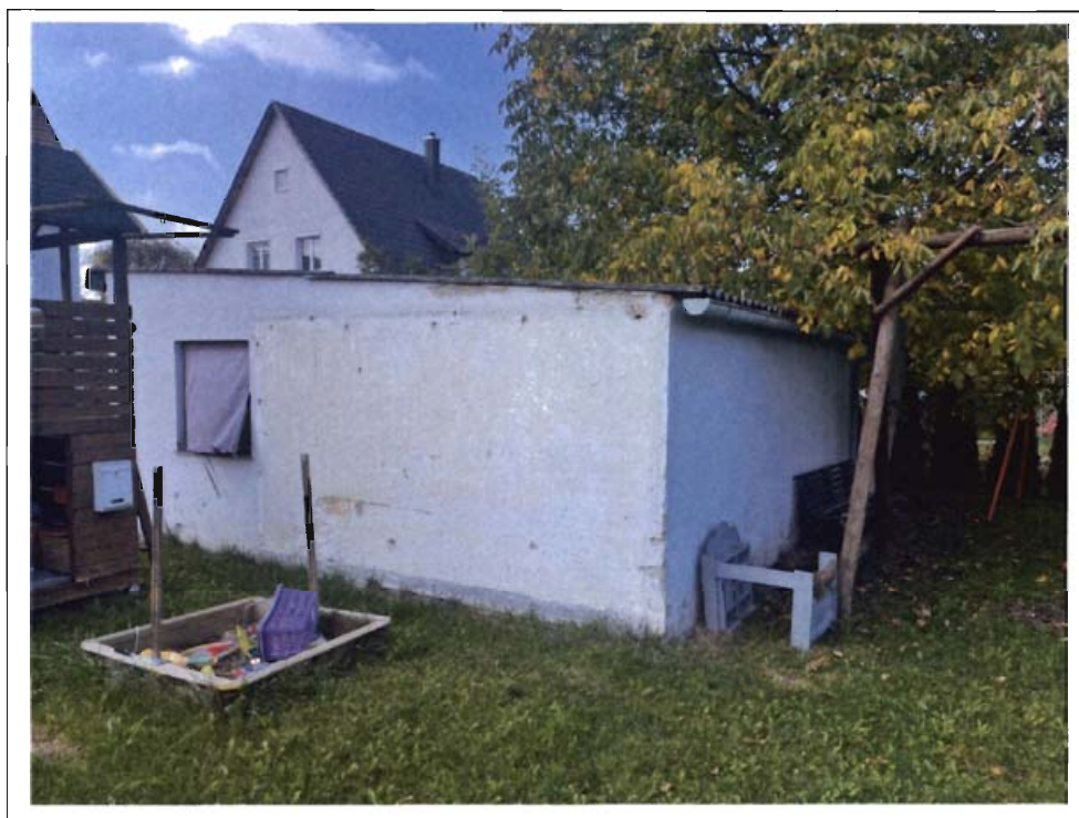
Foto 7: Doppelgarage - Ansticht von Osten
