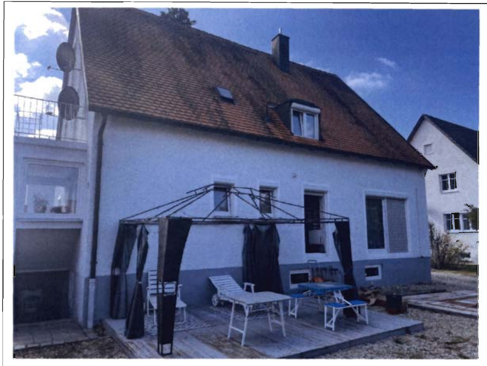
Foto 5: Blick zum Freisitz - Ansicht von Nordosten
