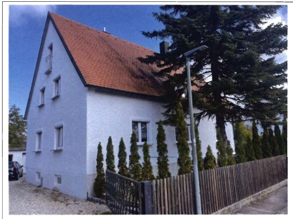
Foto 3: Ansicht von Westen
