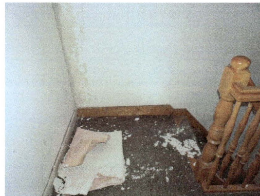
Feuchteschäden Treppenhaus
