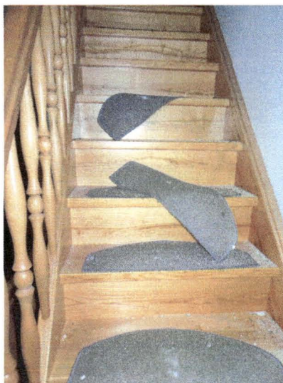
Treppenlauf zum DG
