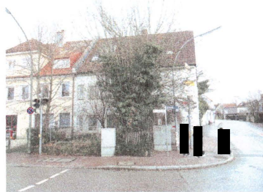
Südwestseite des Gebäudes
