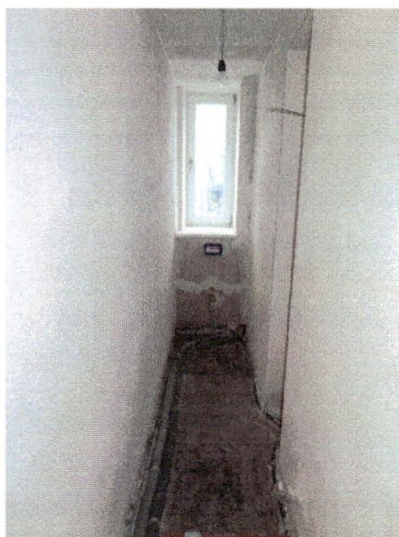
WC-Raum EG (nicht fertiggestellt)
