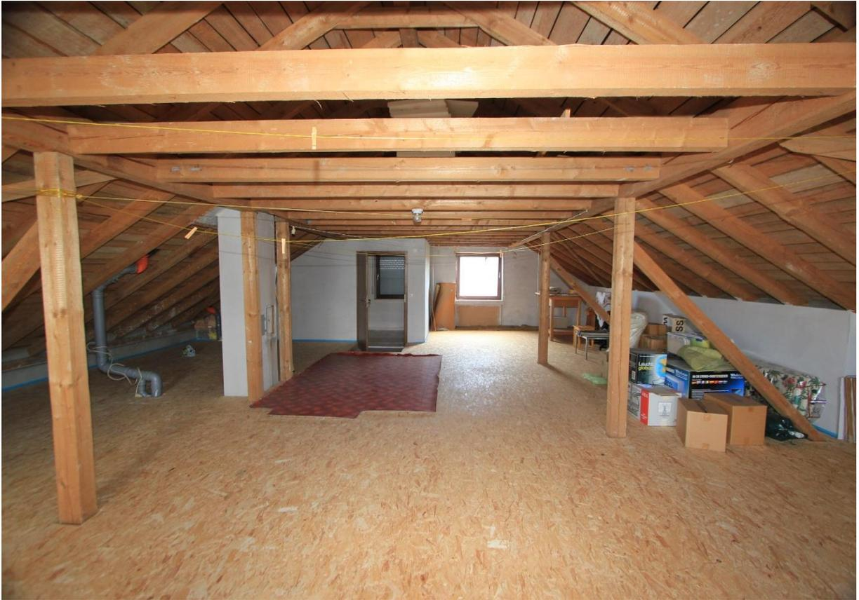
Unausgebauter Dachraum mit aufgedoppeltem Boden
