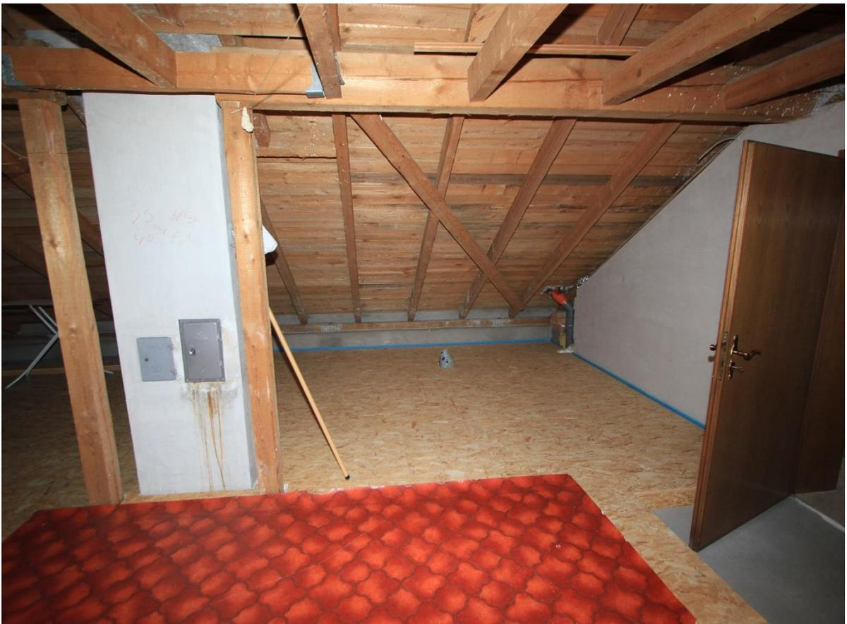
Unausgebauter Dachraum mit aufgedoppeltem Boden
