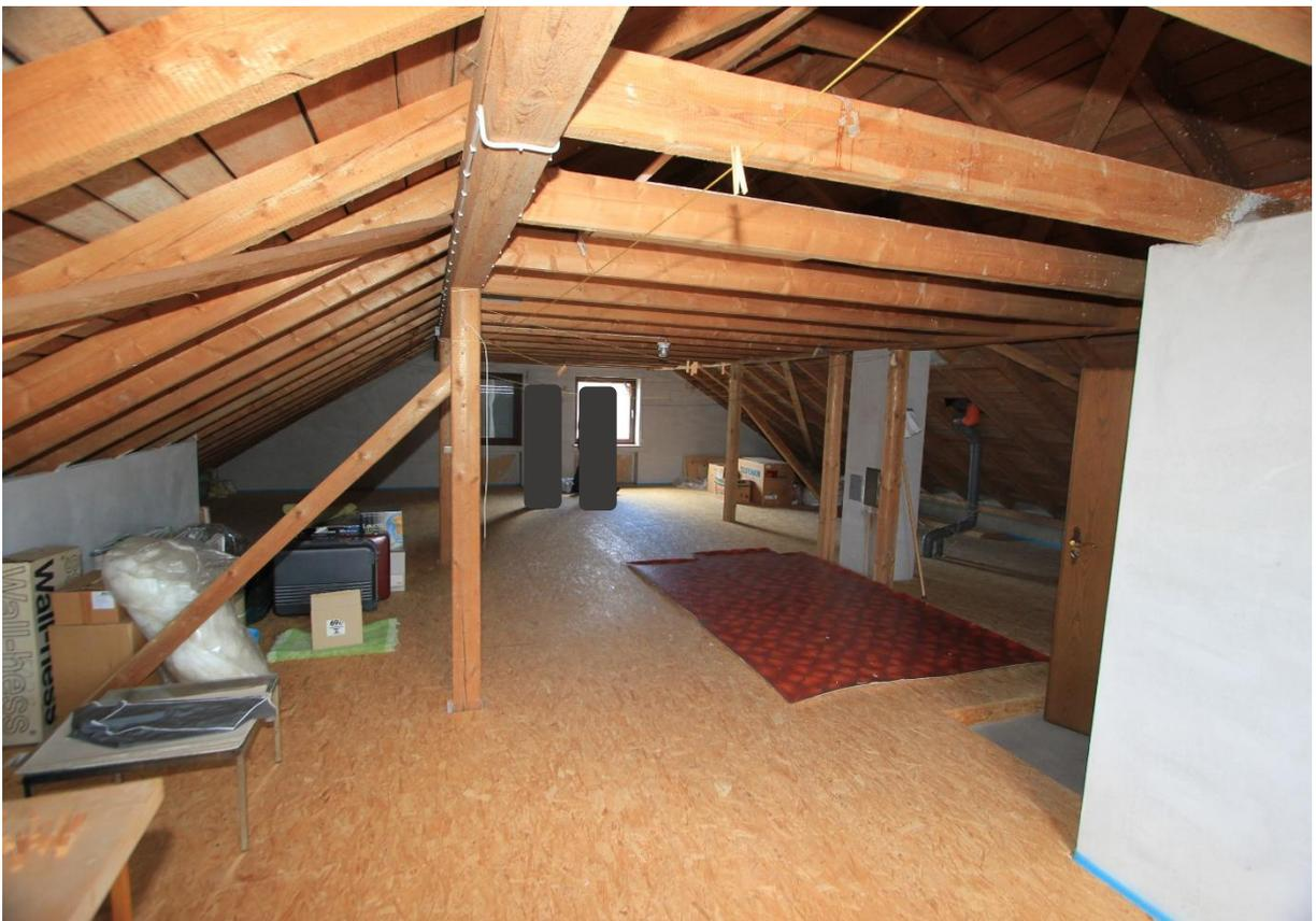
Unausgebauter Dachraum ohne Dachdämmung
