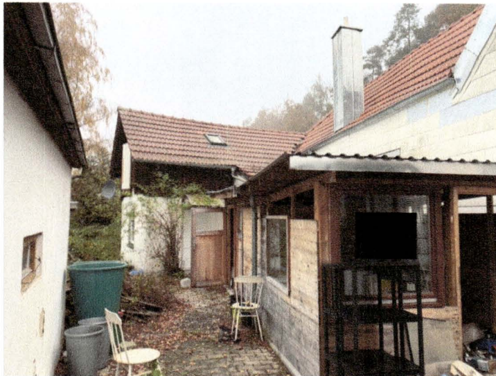
Südostansicht mit Nebengebäude
