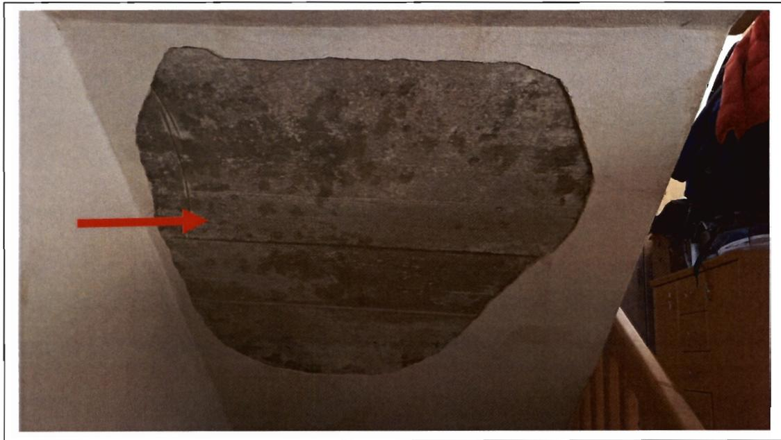
Foto 35: fehlender Putz an der Treppenunterseite im Keller
