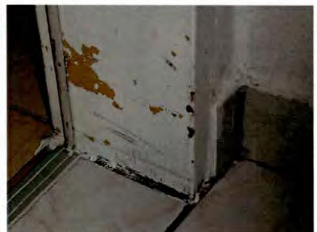
In den Räumen an der Westseite sind Feuchteschäden und dunkle Verfärbungen im Wand-deckenbereich sichtbar. Die Wände im „kleinen Kinderzimmer“ sind mit Gipskartonplatten verklei-det. Der Zustand, der sich dahinter befindlichen Wand, ist nicht sichtbar.
