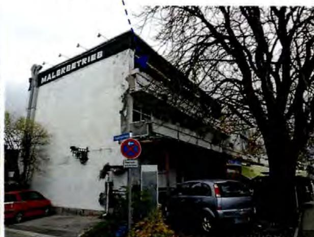
Der Zugang zu den Wohnungen, die sich im 1. und 2. Obergeschoss befinden, ist an der Nordseite. Die verglaste Aluminiumtür ist von einem Vordach überdeckt. Die Verglasung in der Eingangstüre ist beschädigt. Im Seitenteil des Türelements ist eine Klingel-, Gegensprech- und Briefkastenanlage angebracht.
