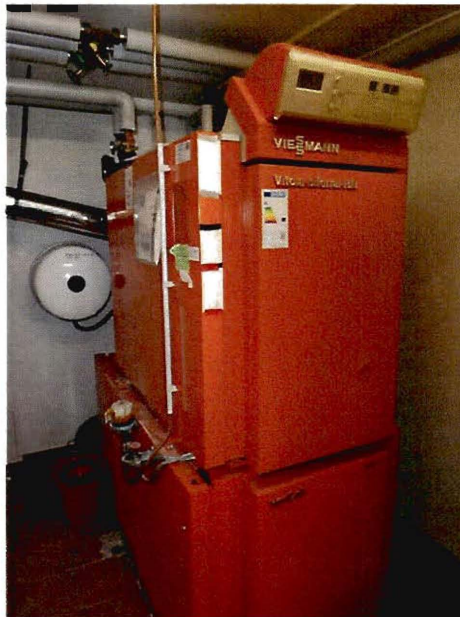
Viessmann, Ölzentralheizungsanlage
