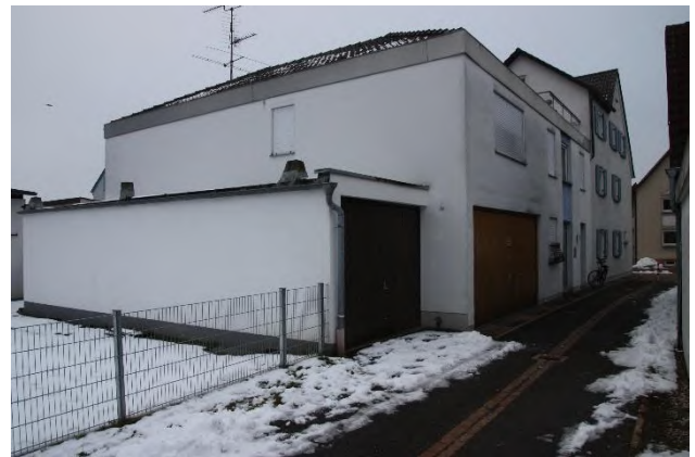
Ansicht von Nordosten mit Nachbarbebauung
