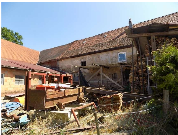
Bauteil 4.4.2 von Nordwesten
