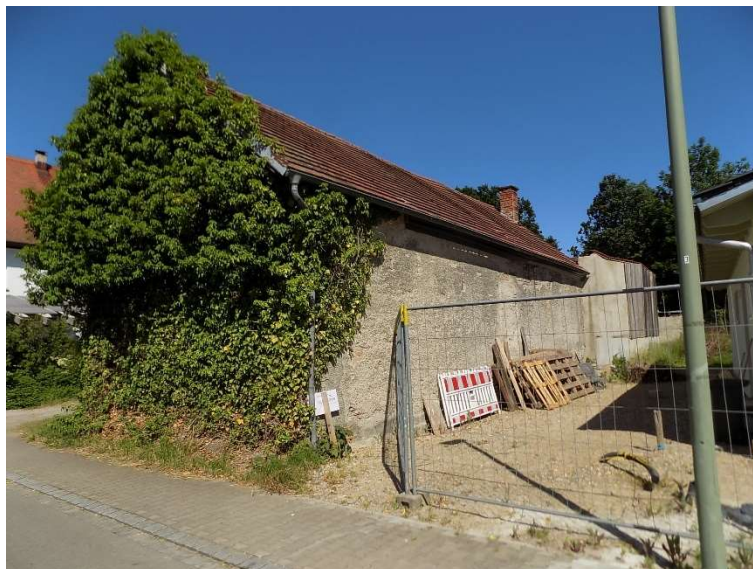
Bauteil 4.4.4 von Südwesten
