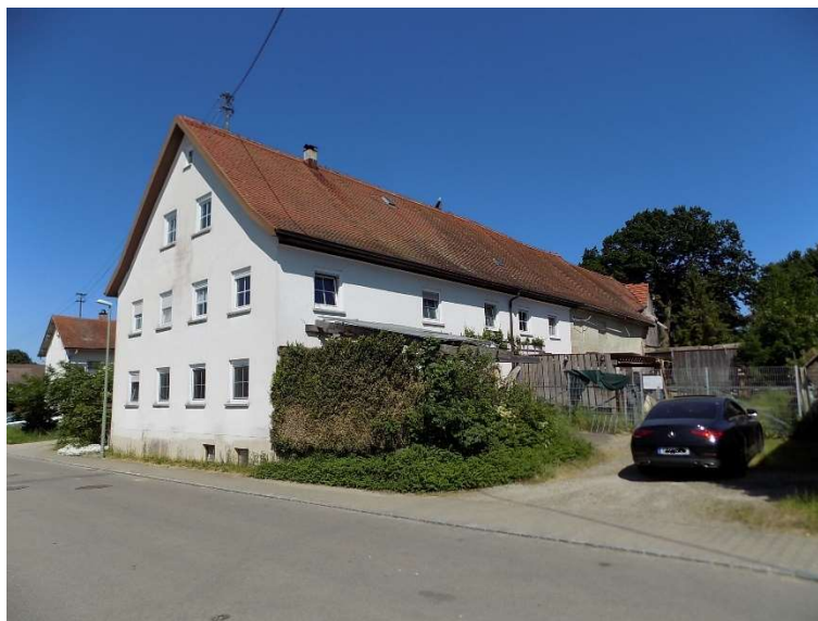
Bauteil 4.4.1 von Südwesten
