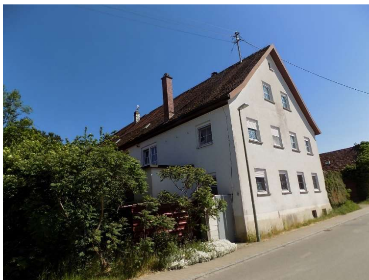
Bauteil 4.4.1 von Nordwesten
