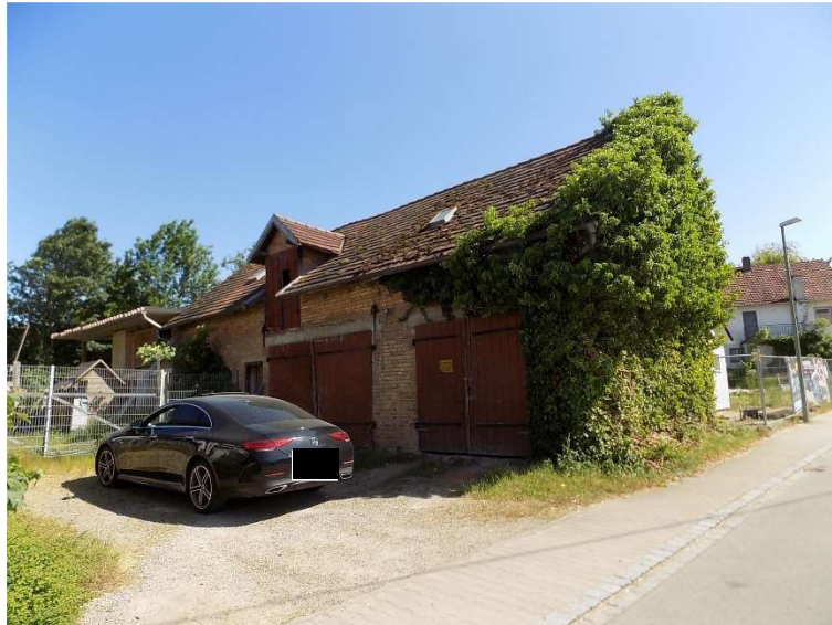
Bauteil 4.4.4 von Nordwesten
