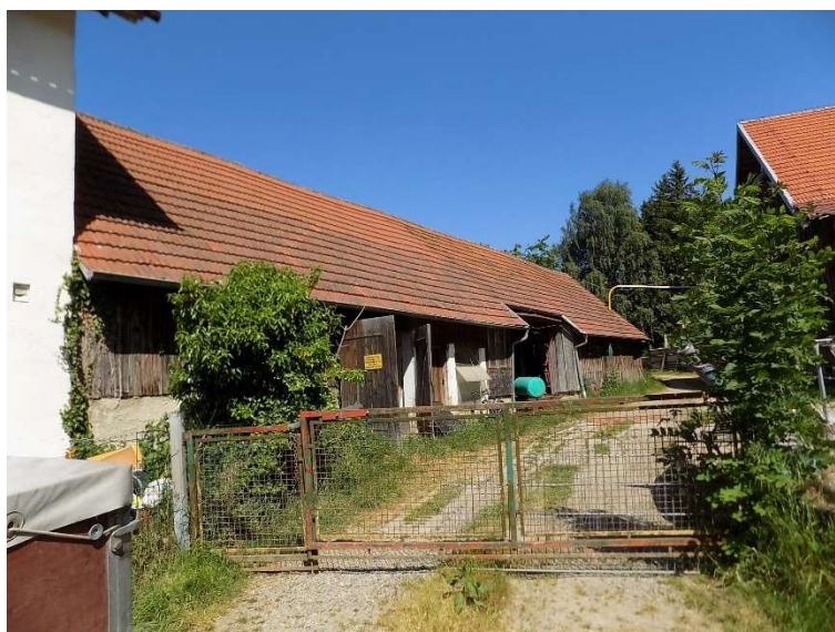
Bauteil 4.4.3 von Südwesten
