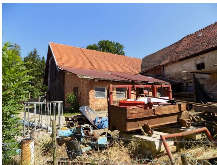
Bauteil 4.4.2 von Nordwesten
