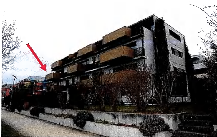
Außenansicht: Mehrfamilienhaus von Südwesten (roter Pfeil = ungefähre Lage der zu bewertenden Wohnung)
