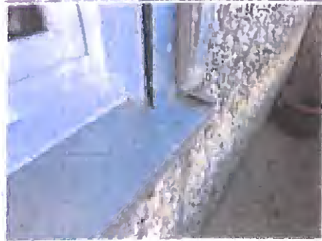
Foto 22: Detailanschluss Fensterbank
