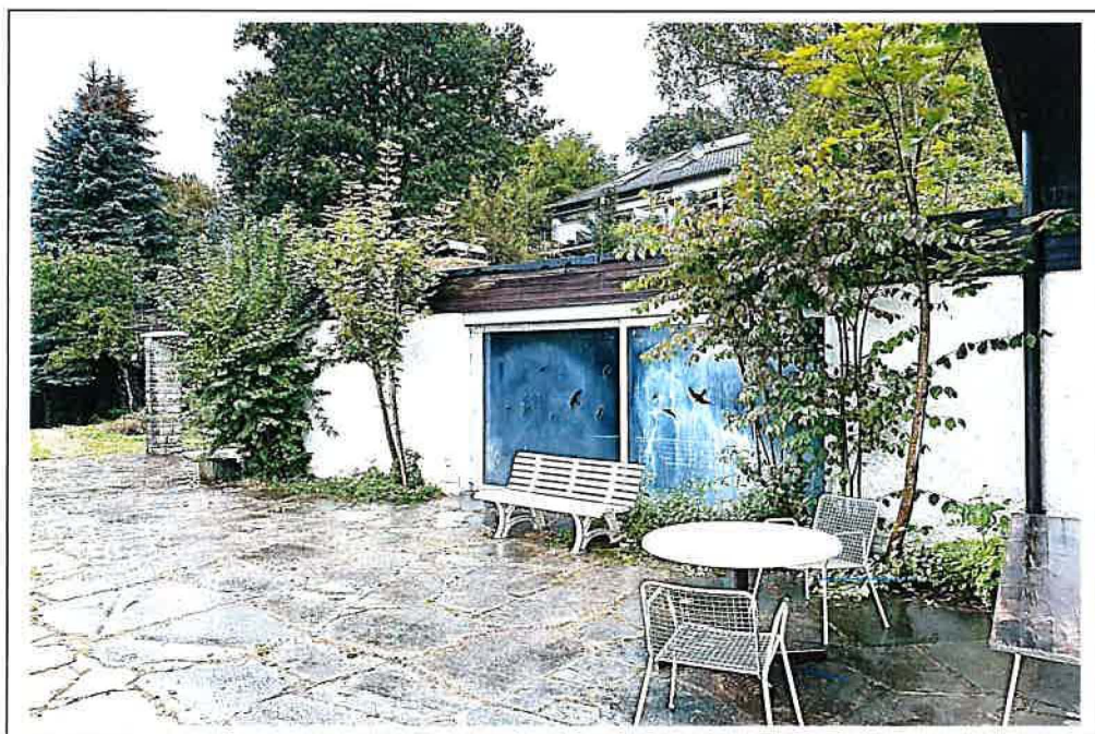
Foto 4: 89275 Oberelchingen; Heusteige 30, Ansicht Anbau (ehem. Bad)
