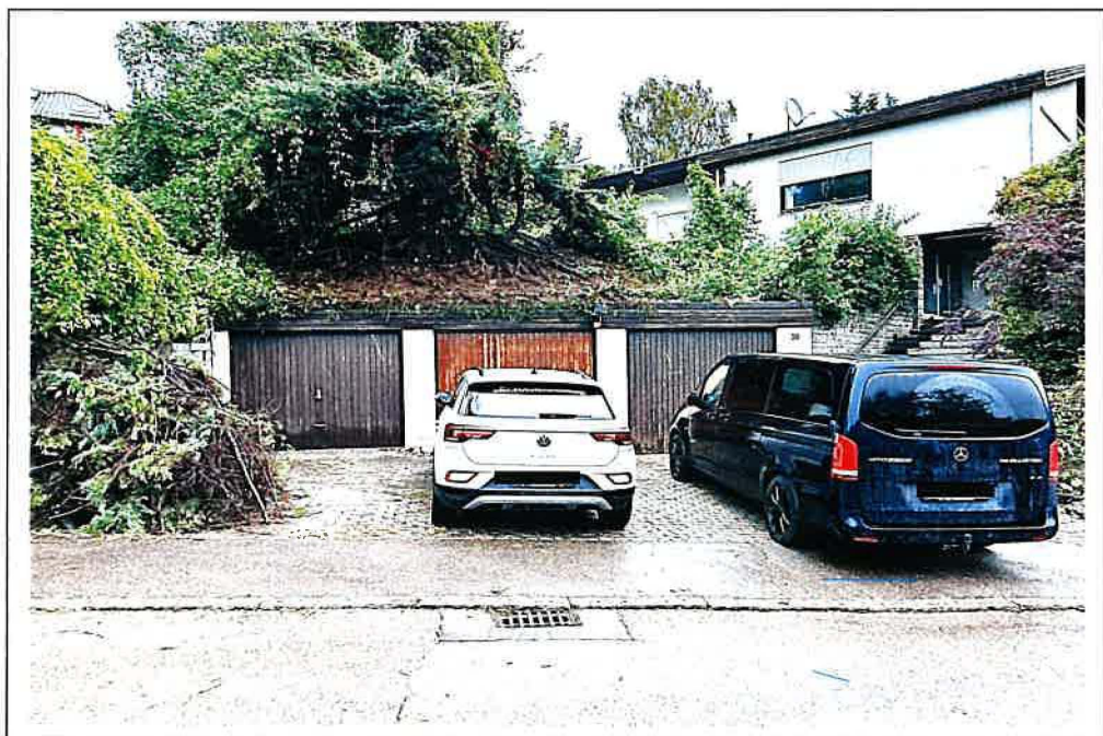
Foto 6: 89275 Oberelchingen; Heusteige 30, Ansicht Garagen
