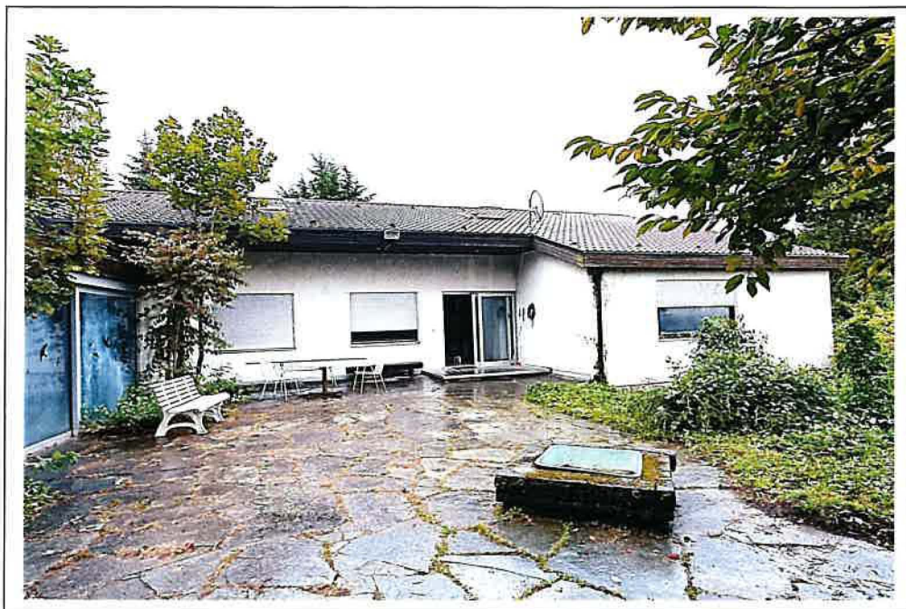
Foto 3: 89275 Oberelchingen; Heusteige 30, Ansicht West
