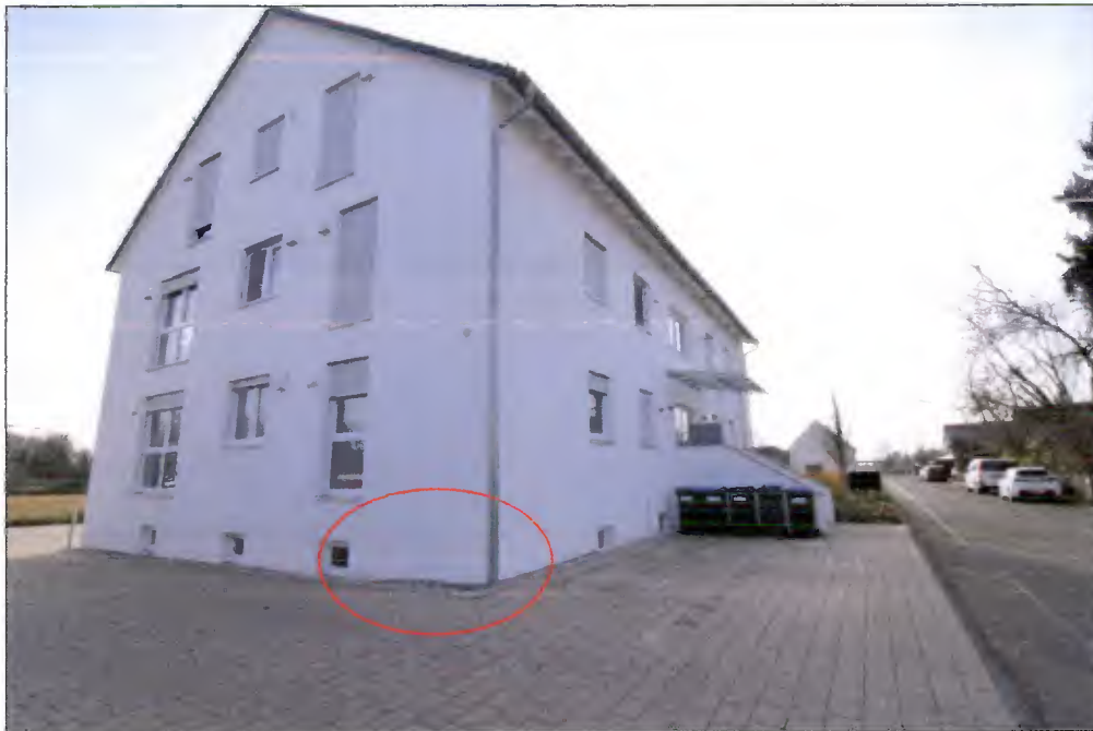
Leichte Ausblühungen an der Fassade
