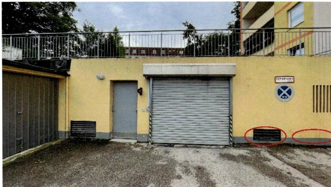
36 Garage, Blick auf die Ostfassade mit Zugangstor, verbogenes Lüftungsgitter und Nässe Spuren im unteren Drittel der Wand
