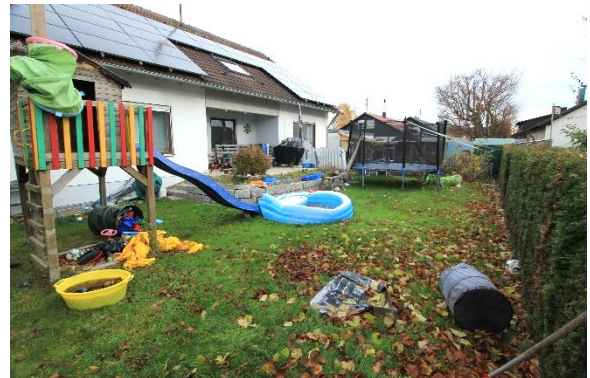
Blick in den südlichen Garten
