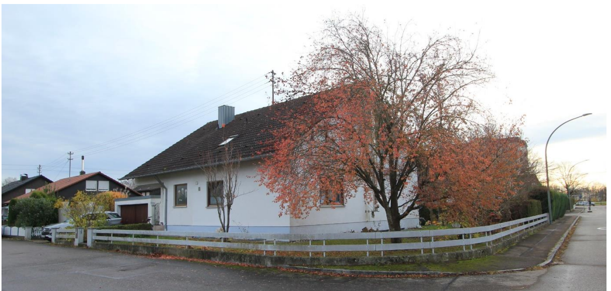
Grundstück mit Doppelgarage und Wohnhaus von Nordwesten
