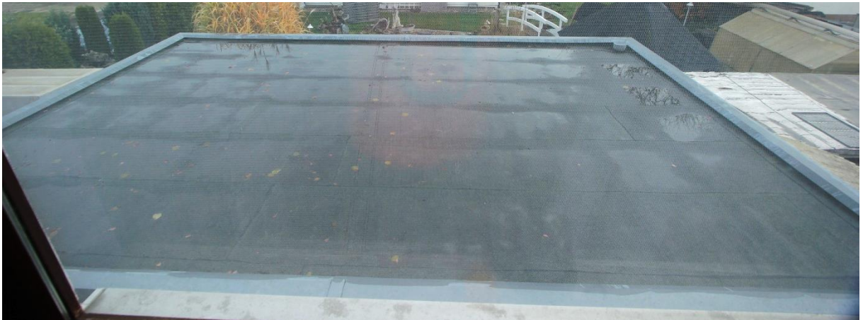
Garagendach von oben
