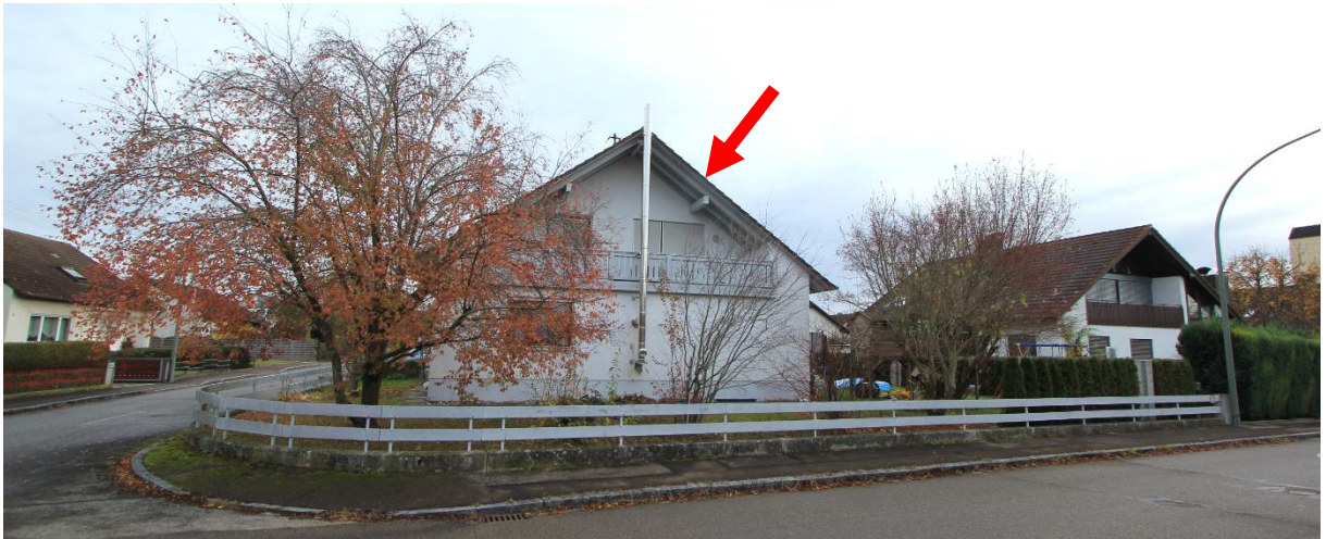
Grundstück mit Wohnhaus von Westen
