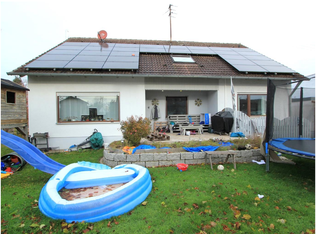
Wohnhaus und Garten von Süden, auf dem Dach Photovoltaikanlage
