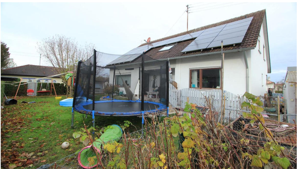
Wohnhaus von Südosten, links südlicher Garten
