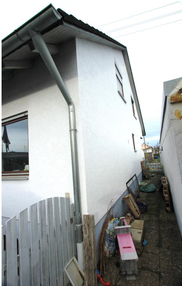
Ostgiebelseite Wohnhaus und Gang
