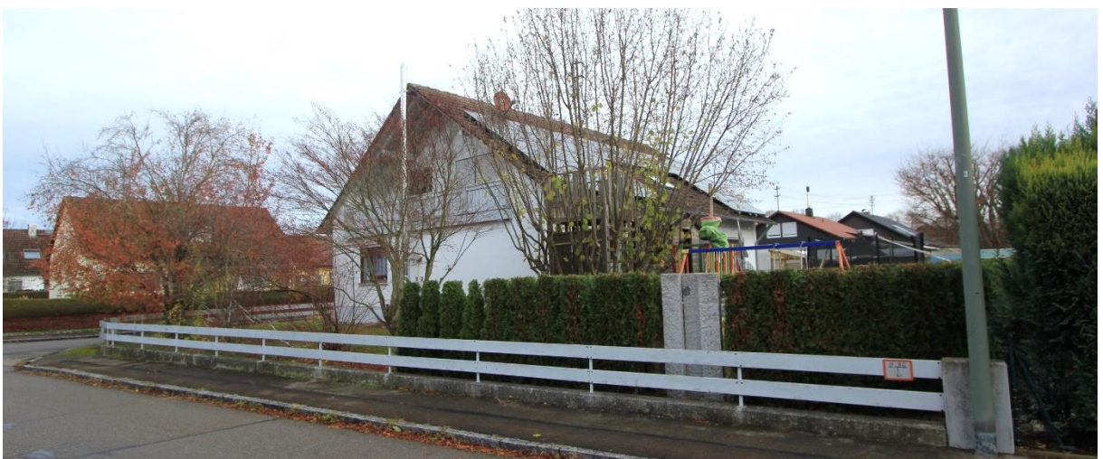
Grundstück mit Wohnhaus von Südwesten
