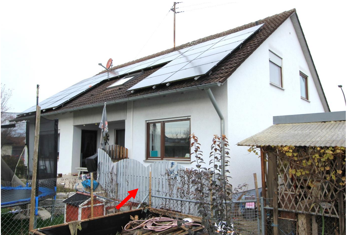
Wohnhaus von Südosten mit PV-Anlage, Pfeil Geländer Kelleraußentreppe
