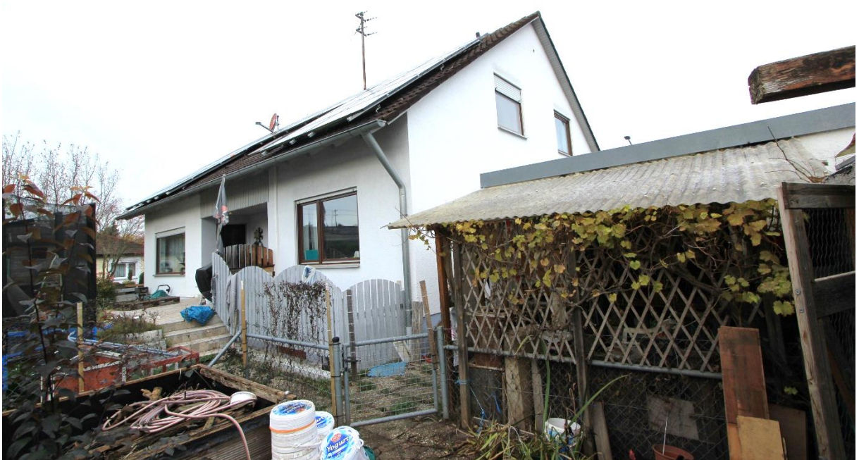
Wohnhaus von Osten, rechts Schuppen vor dem offenen Abstellraum
