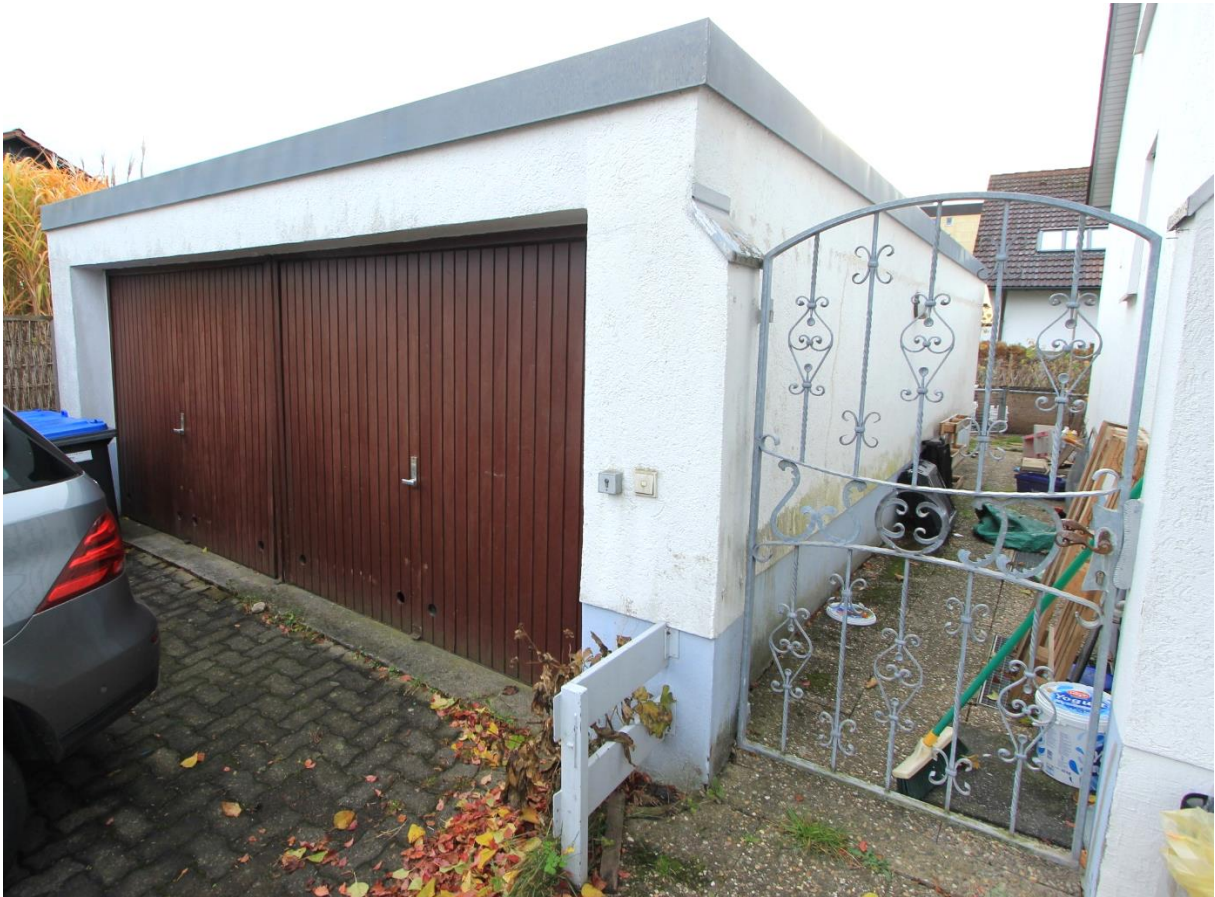
Doppelgarage mit Kipptoren, rechts davon Umgang
