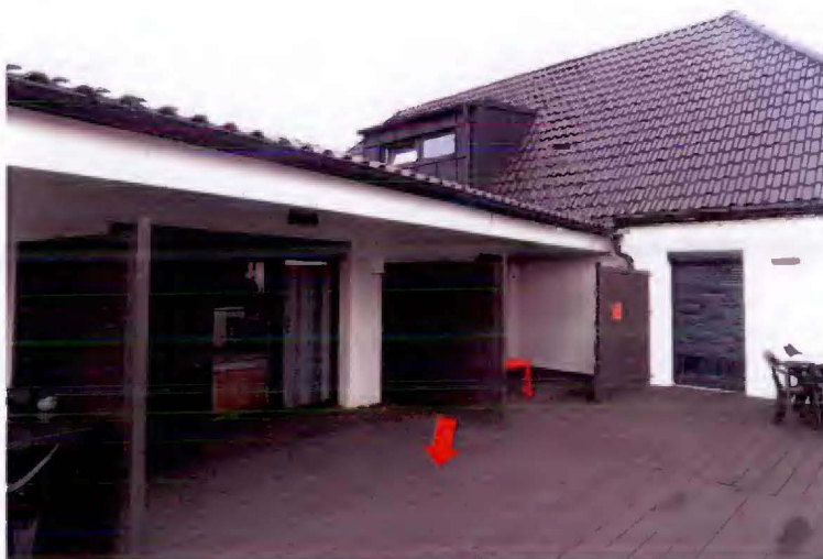
Whg. Nr. 9: Dachterrasse
