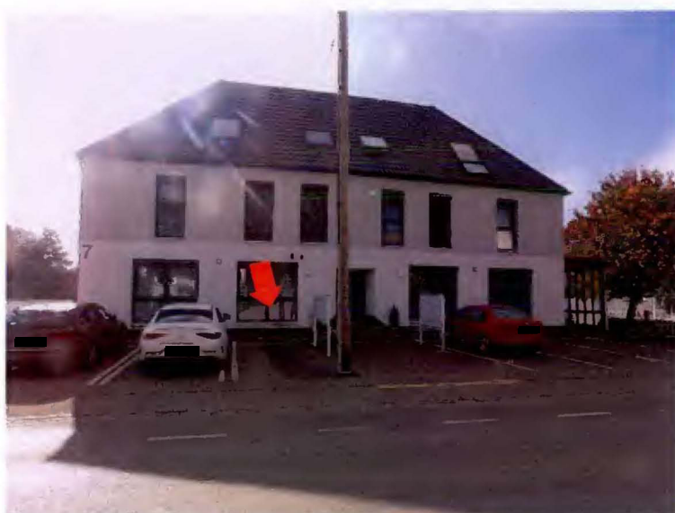
Ansicht der Wohnanlage von Norden, Pfeil: Stellplatz Nr. 28 zur Sondernutzung für jeweiligen Eigentümer der Wohnung Nr. 9
