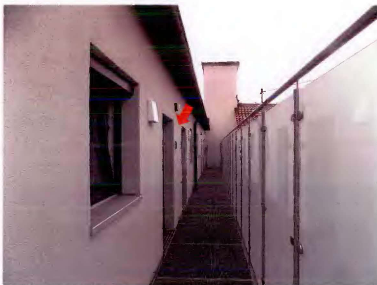
Laubengang zur Wohnung, Pfeil: Tür zur Wohnung Nr. 9
