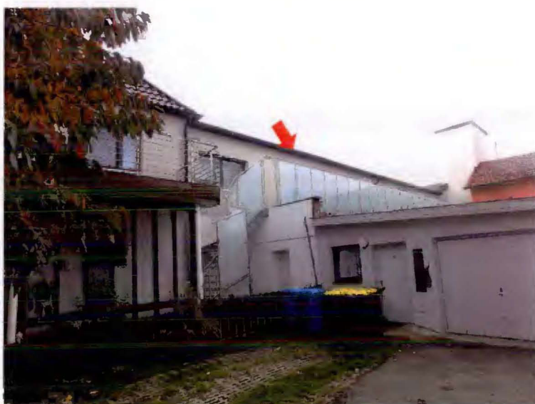
Ansicht von Nordwesten, Pfeil: Laubengang zur Wohnung
