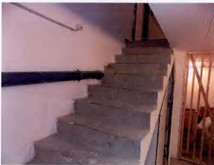
Treppe zum Keller
