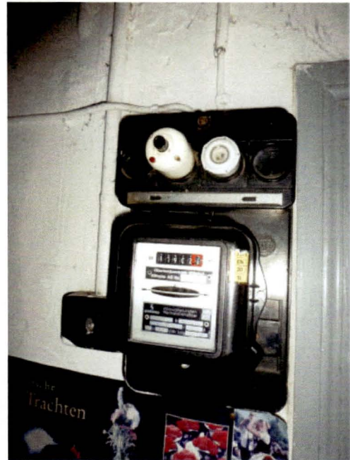
Elektrohauptabsicherung
