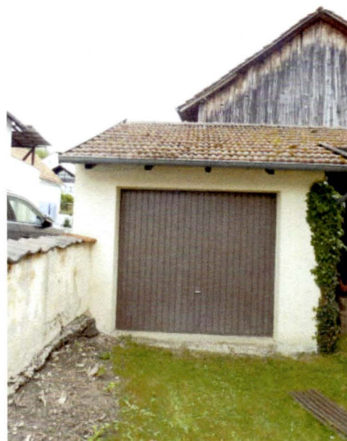
Nordwestfassade der Garage
