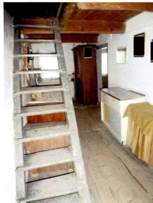
Flur im 1. OG
