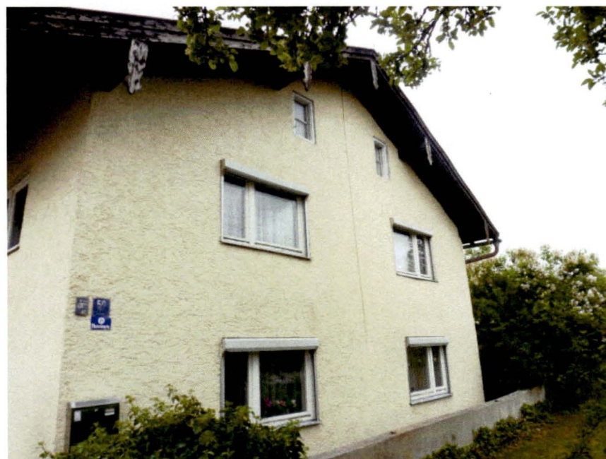
Nordwestfassade des Einfamilienhauses
