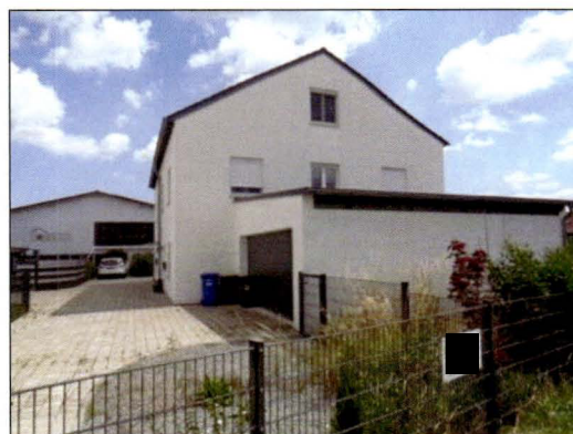
Hoffläche und Westfassaden DHH u. Garage
