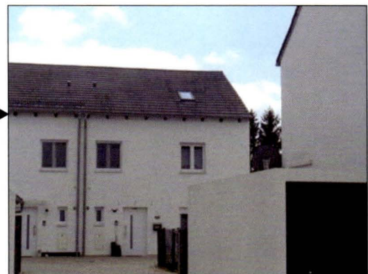
Bewertungsobjekt Hausnr. 2d: Nordfassade DHH
