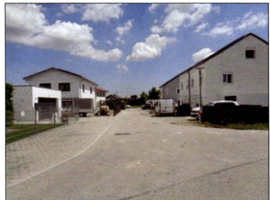
Straße „Stadlwiesen“, Blick von Gemeindestraße
