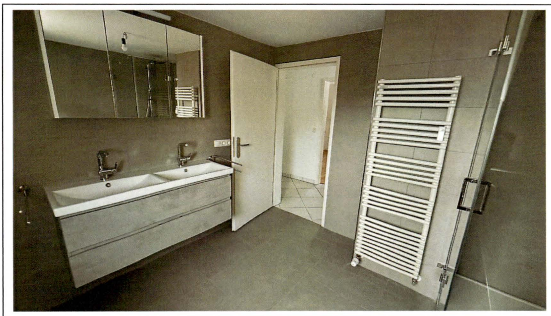
Foto 33: Blick in das Bad (Wohnung Nr. 2)
