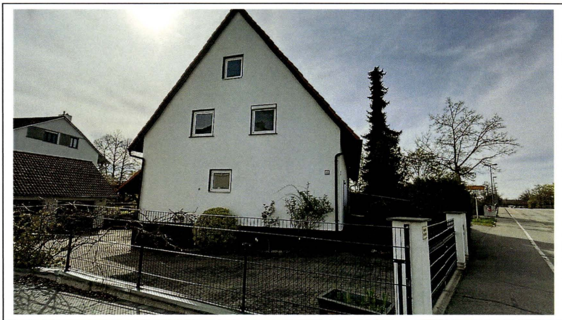
Foto 2: Ansicht von Norden
