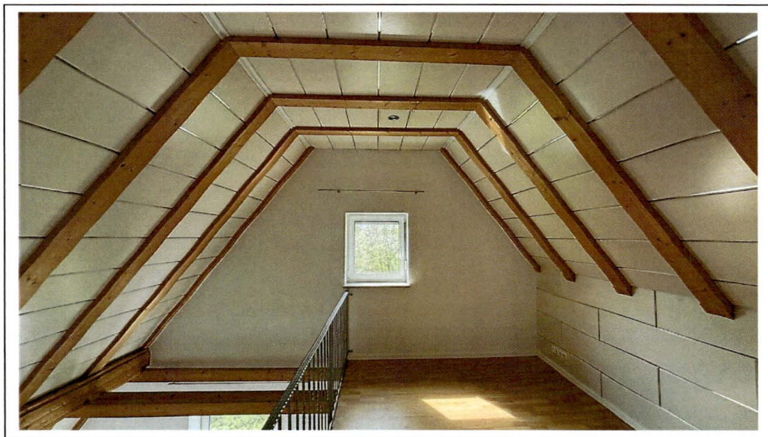
Foto 36: Blick in die Galerie (2.DG, Wohnung Nr. 2)
