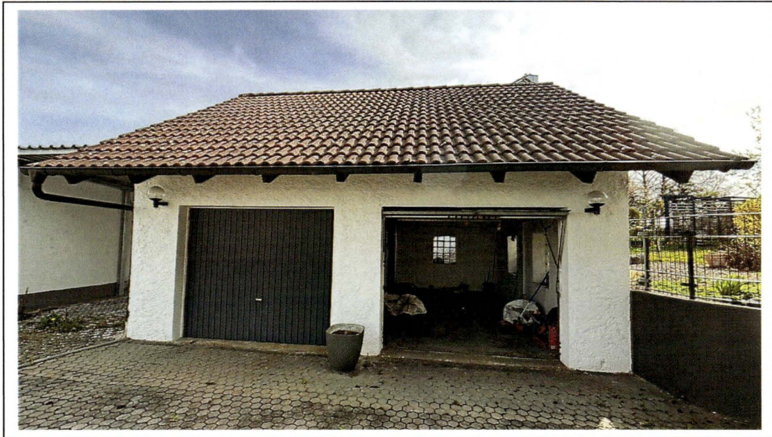
Foto 10: Doppelgarage – Ansicht von Westen
