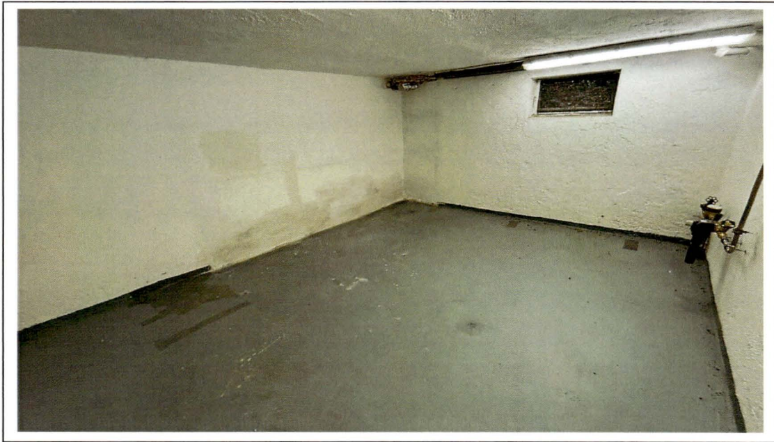
Foto 42: Blick in einen Abstellraum
