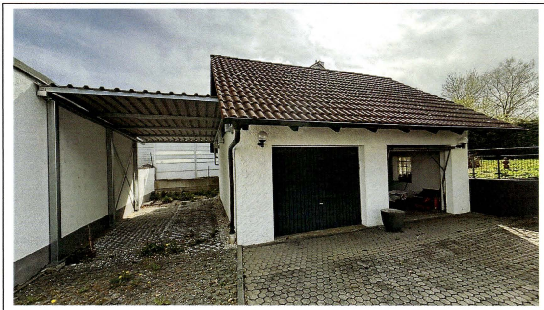
Foto 9: Doppelgarage und Carport – Ansicht von Westen
