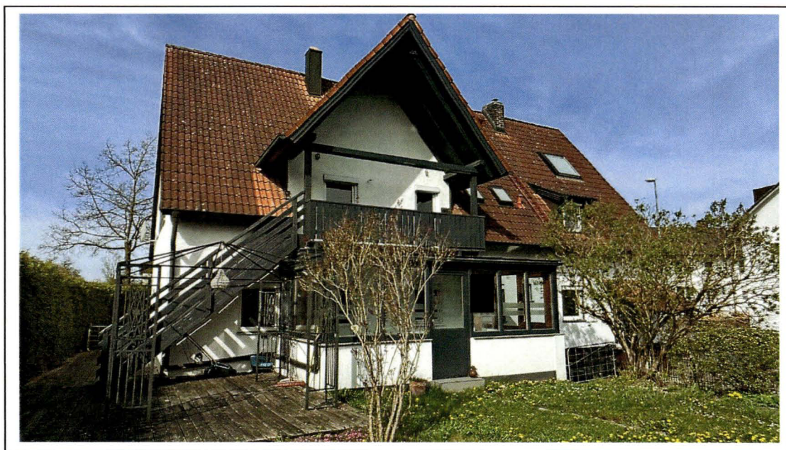
Foto 4: Ansicht von Osten
