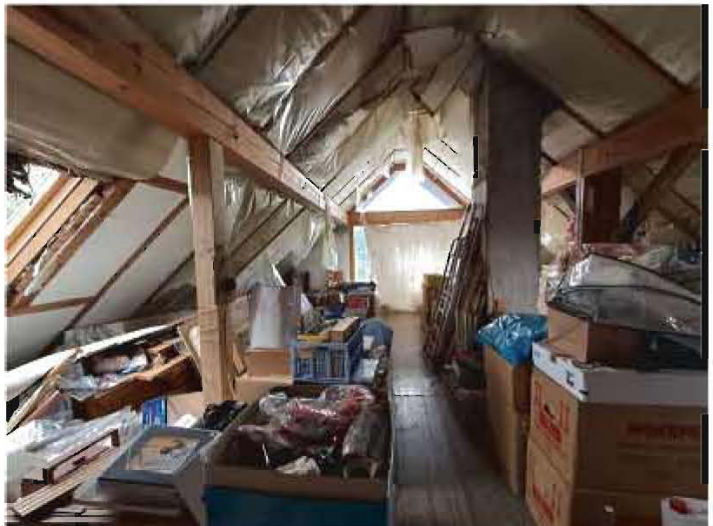
Wohneinheit Nr. 2; leerstehend; im Ausbau befindlich (DG)
