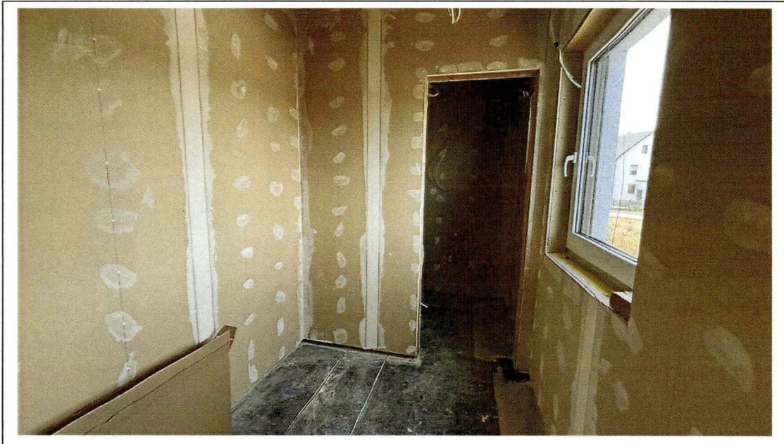
Foto 11: Garderobe mit Blick zum WC
