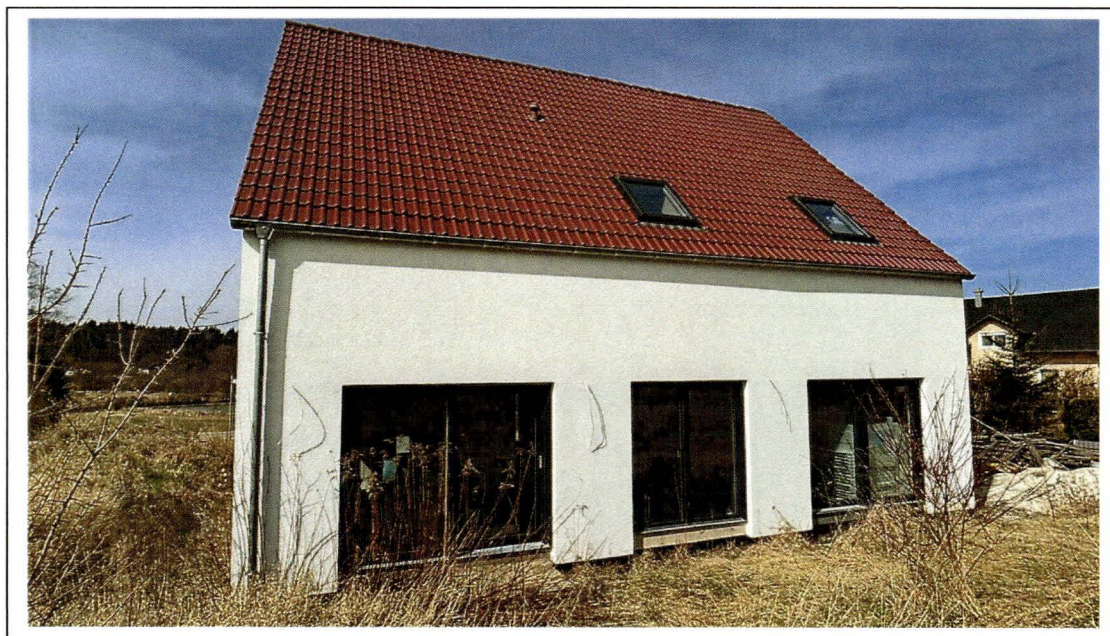
Foto 5: Ansicht von Südosten
