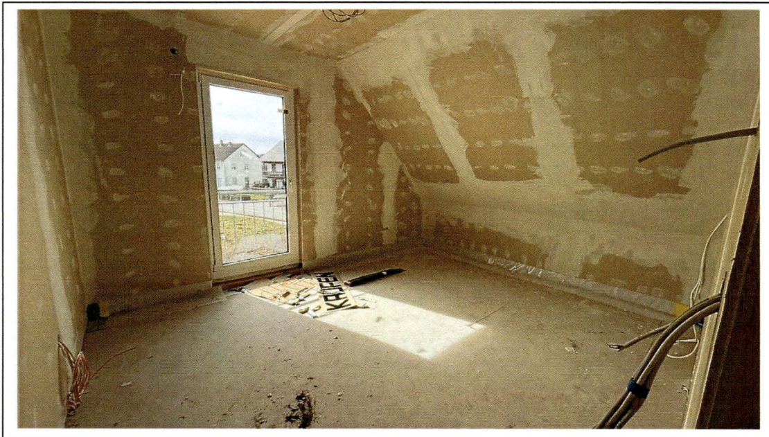
Foto 17: Blick in das Kinderzimmer 2
