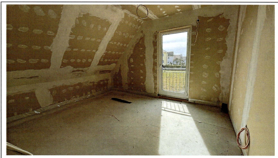
Foto 18: Blick in das Kinderzimmer 1
