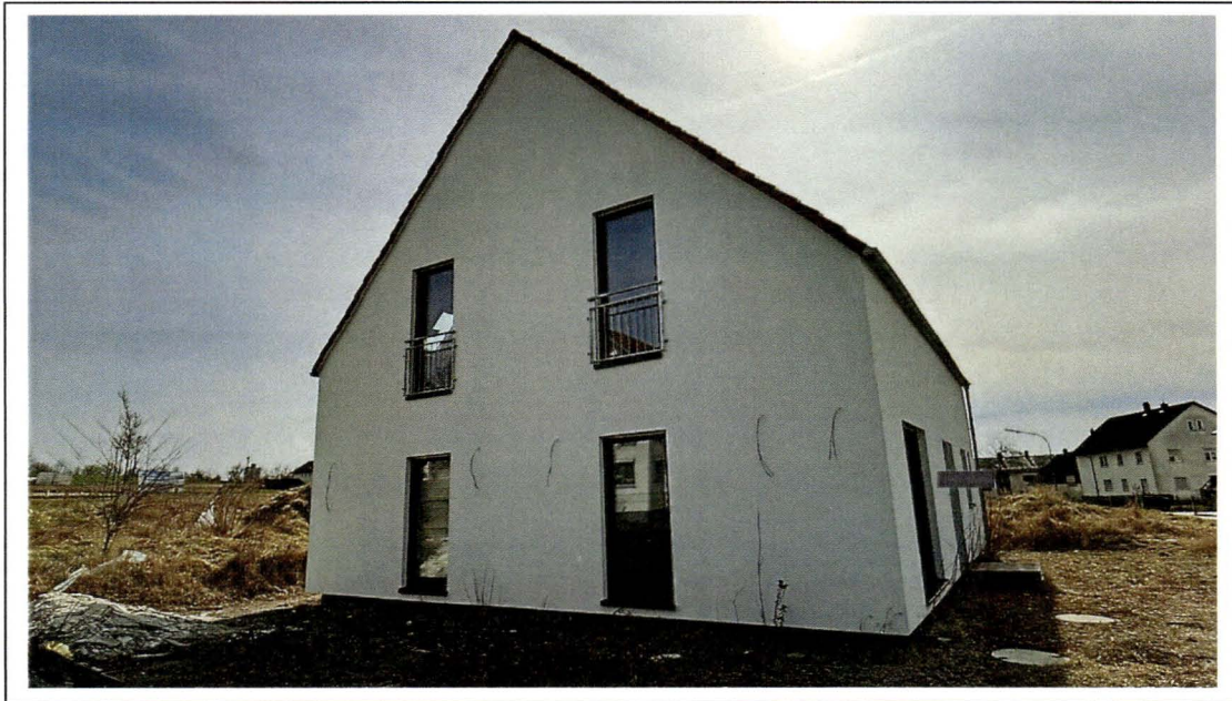
Foto 1: Ansicht von Norden
