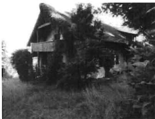
Südost- und Südwestseite des Gebäudes
