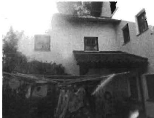
Nordwestseite des Garagenanbaus
