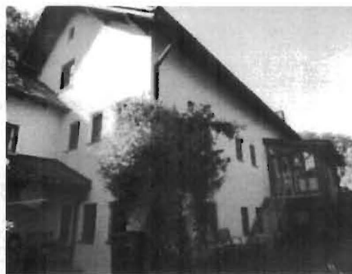
Nordost- und Nordwestseite des Gebäudes
