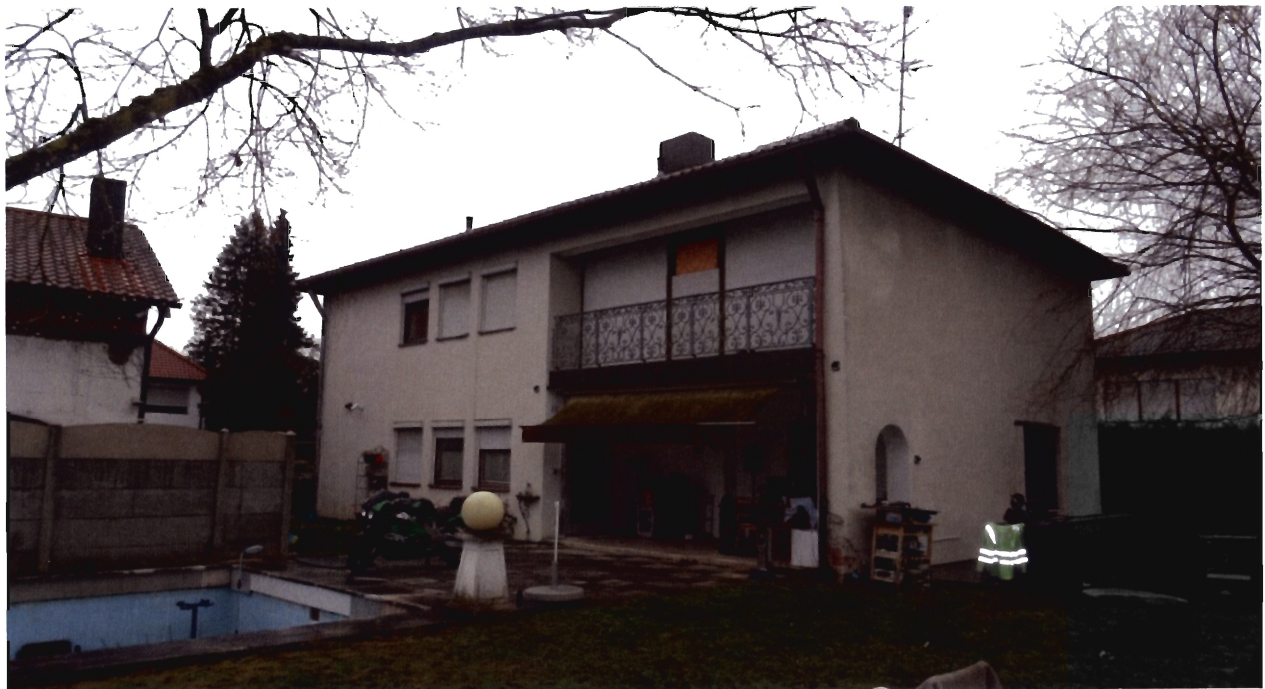
Ansicht auf das Wohngebäude von Süden
