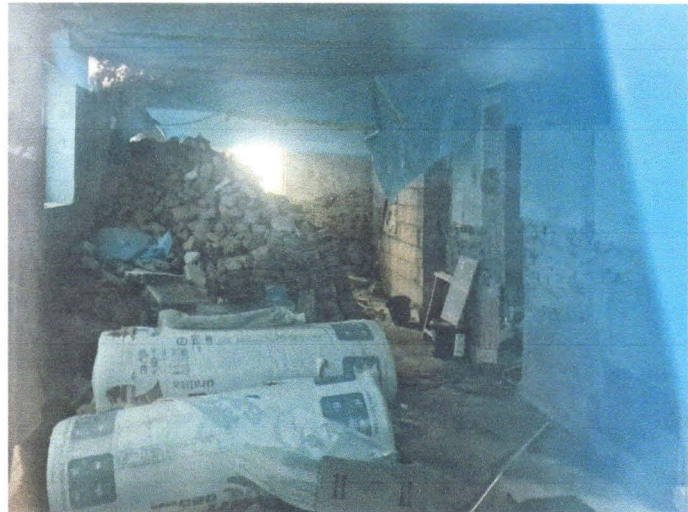
Einheit Erdgeschoss im Rohbauzustand
