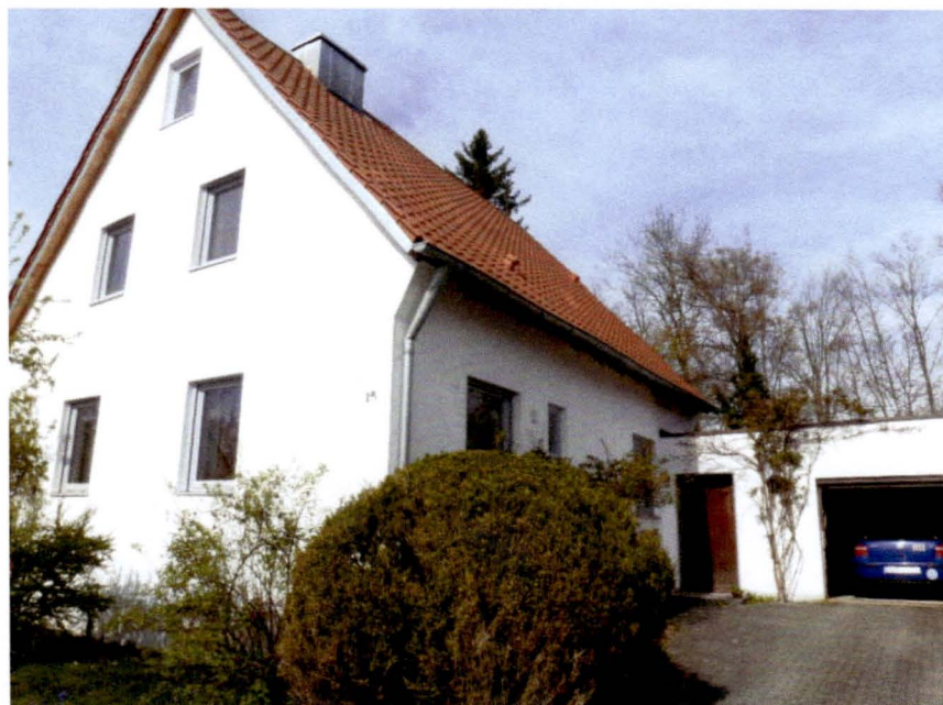
Blick von Südosten auf das Einfamilienhaus mit Nebengebäude
