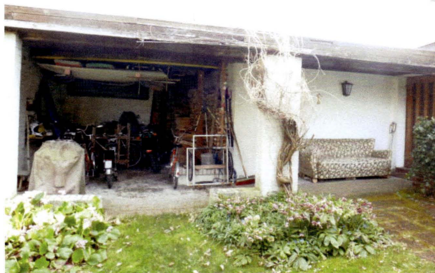
Blick von Südwesten auf das Nebengebäude
