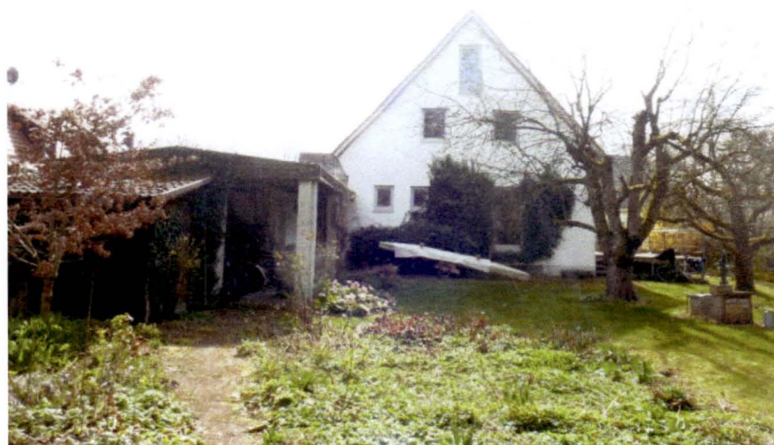
Blick von Nordwesten auf das Einfamilienhaus mit Nebengebäude
