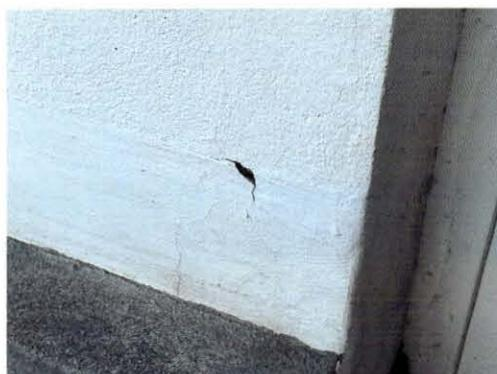
beispielhafte Ansicht des sich zum Teil lösenden Mauerwerks im Sockelbereich des Mehrfamilienhauses
