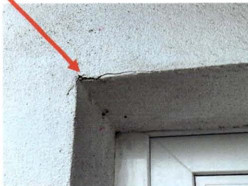
beispielhafte Ansicht eines Risses im Bereich des Türsturzes der Eingangstüre zum Windfang und Zugang der Wohnung Nr. 1
