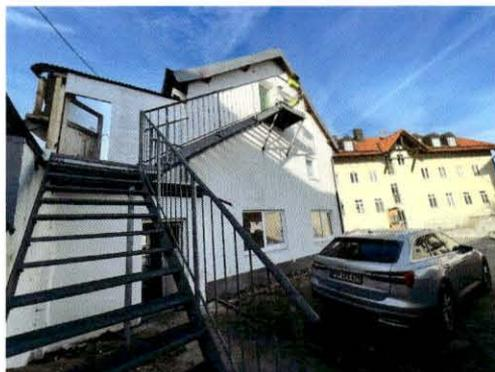
beispielhafte Ansicht des Treppenaufgangs ins Obergeschoss und Dachgeschoss mit einem vermutlich fehlenden zweiten Treppengeländer
