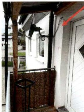
beispielhafte Ansicht der wenig fachmännisch verlegten Leitung zur Installation der Satellitenschüssel im Erdgeschoss
