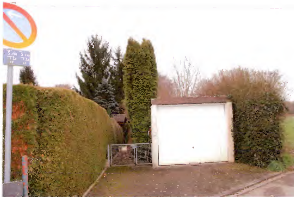
Außenansicht: Einzelgarage auf Grundstück Flst.-Nr. 89/1
