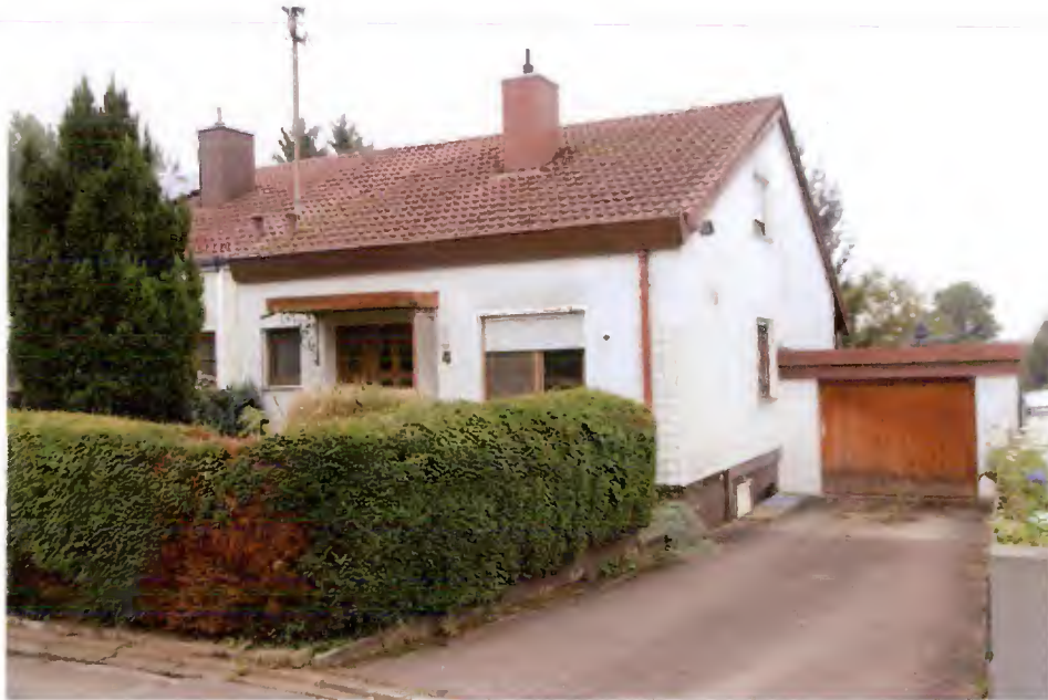
Außenansicht: Doppelhaushälfte von Nordosten
