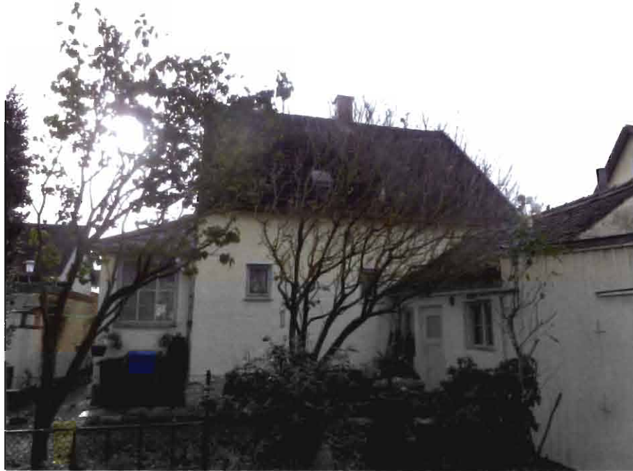
Blick von Norden auf das Wohn- und Nebengebäude
