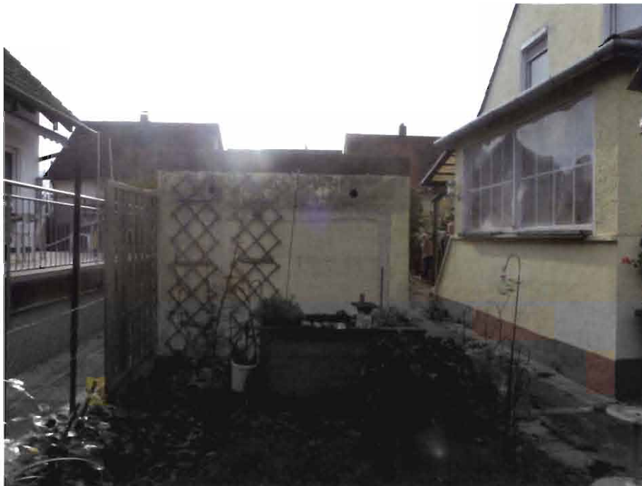
Blick von Norden auf die Garage
