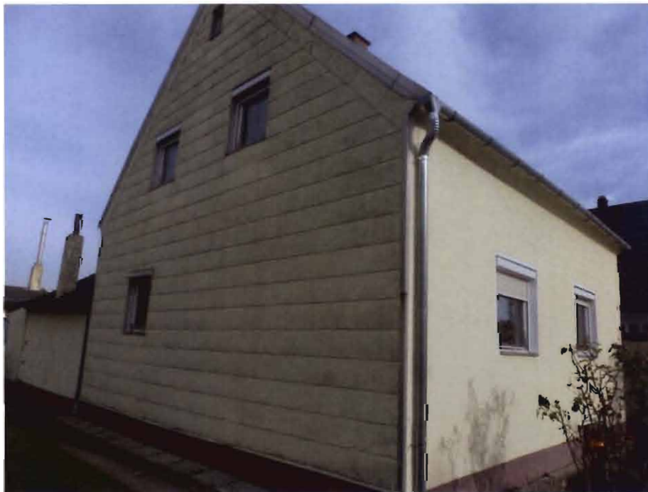
Blick von Südwesten auf das Wohn- und Nebengebäude
