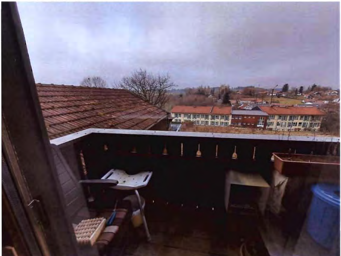
32 Wohnung Nr. 3 DG, Balkon in Westausrichtung
