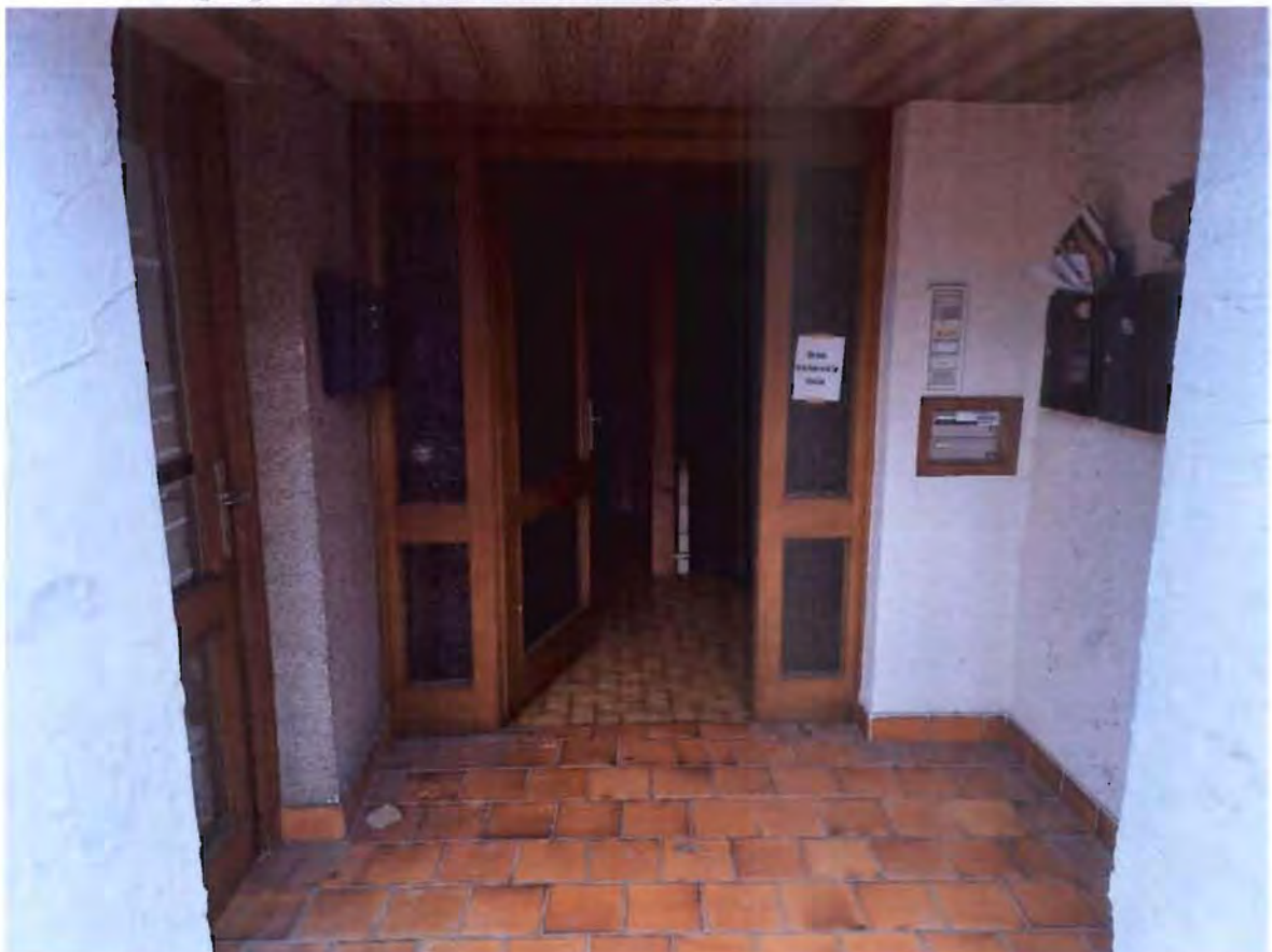
10 Eingangsbereich, Haustüre Vordereingang
