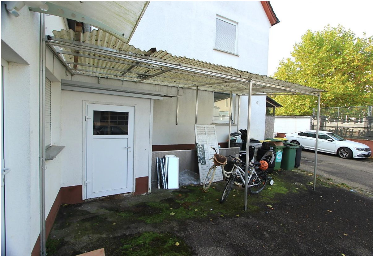
Überdachter Hofbereich nördlich vom Wohnhaus BV 3, links Nachbaranbau
