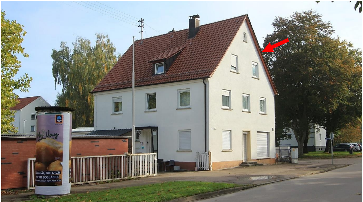
Blick von Südwesten, Pfeil Wohnhaus BV 3
