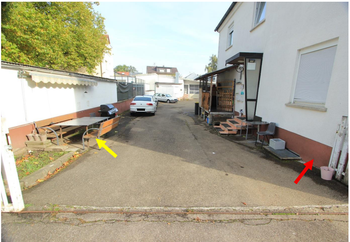
Zufahrt auf Nachbarflurstück 1033/101, links Hof Flst. 1033/121 BV 2, rechts Wohnhaus BV 3
