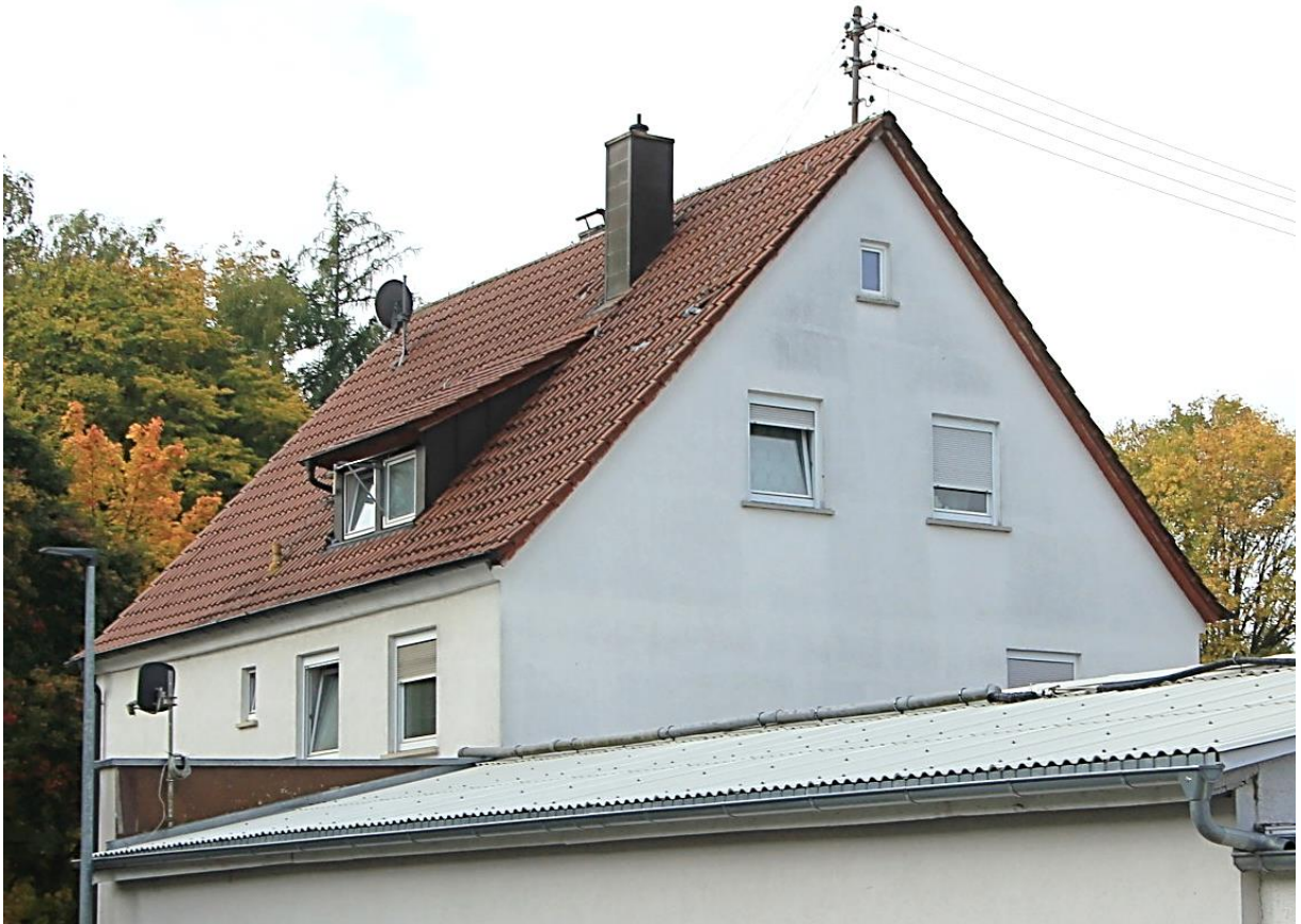
Ostdach und Nordgiebel Wohnhausgrundstück BV 3 von Nordosten
