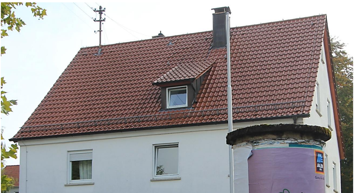
Westdach des Wohnhauses mit kleiner Schleppgaube und Dachziegeldeckung
