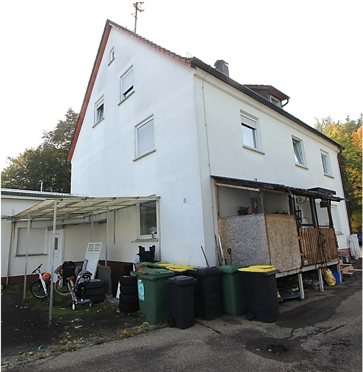
Wohnhausgrundstück BV 3 von Nordwesten, links überdachte Hofffläche, rechts Podestaufbau
