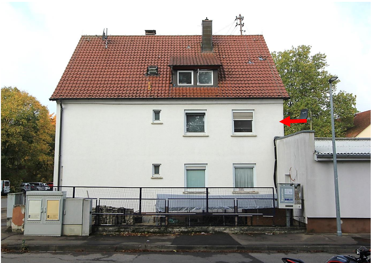
Ostseite Wohnhaus mit Garten und Stahlzaun, rechts nördlicher Anbau (Nachbar)
