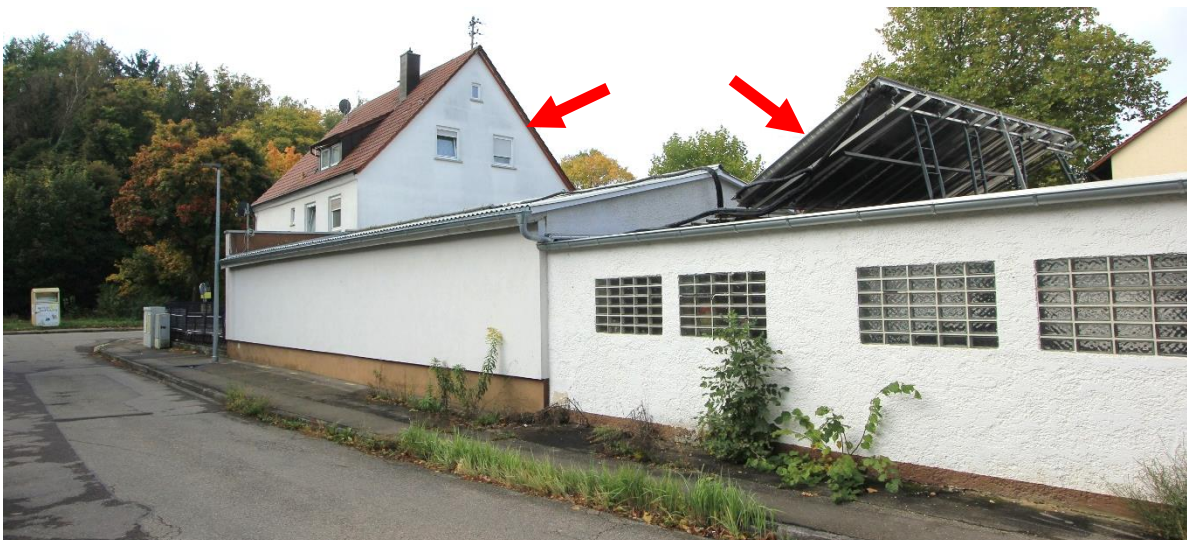
Blick von Nordosten, Pfeil rechts Solaranlage auf Flst. 1033/119 (BV 4 zu 3)
