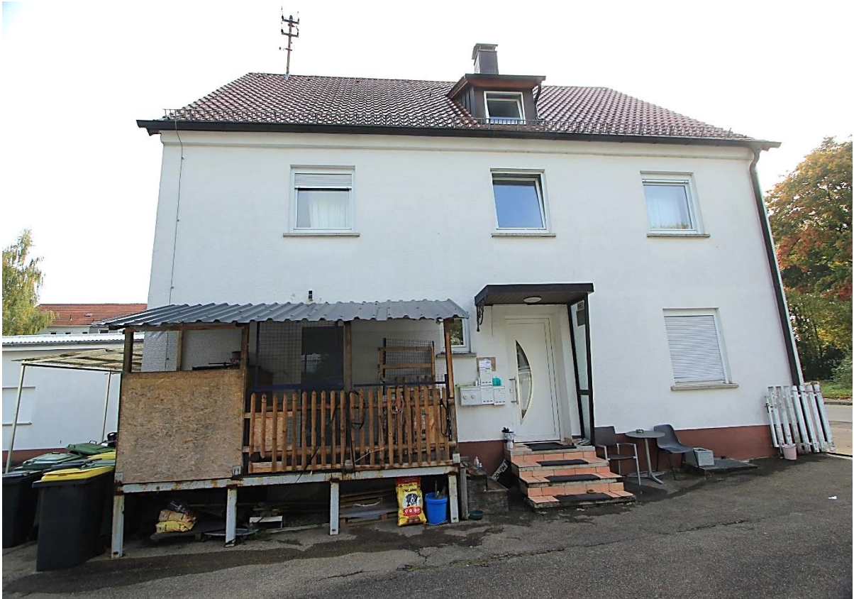
Westseite Wohnhaus BV 3 mit überdachtem Podestanbau und Hauseingang (Überbauten)
