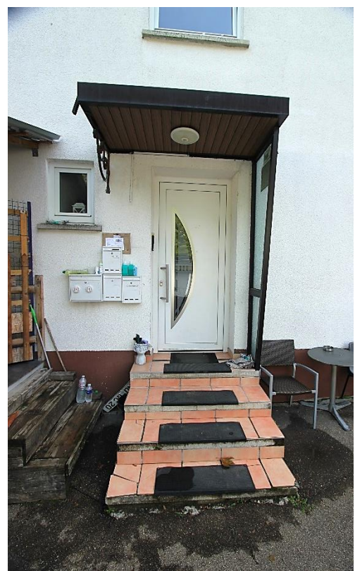
Überdachter Hauseingang (Überbau)
