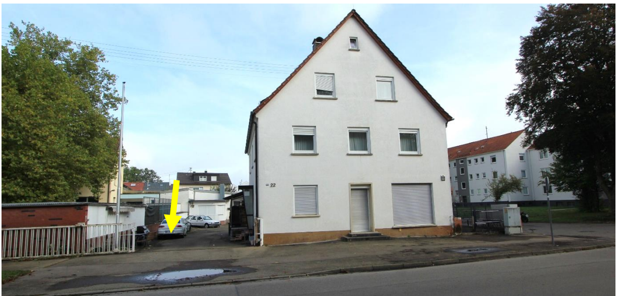
Blick von Süden, links Hof Flst. 1033/121 BV 2, rechts Wohnhaus BV 3
