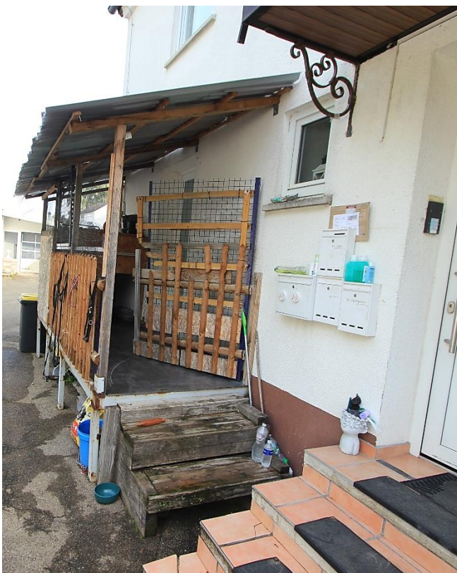
Überdachter Podestanbau westlich am Wohnhaus
