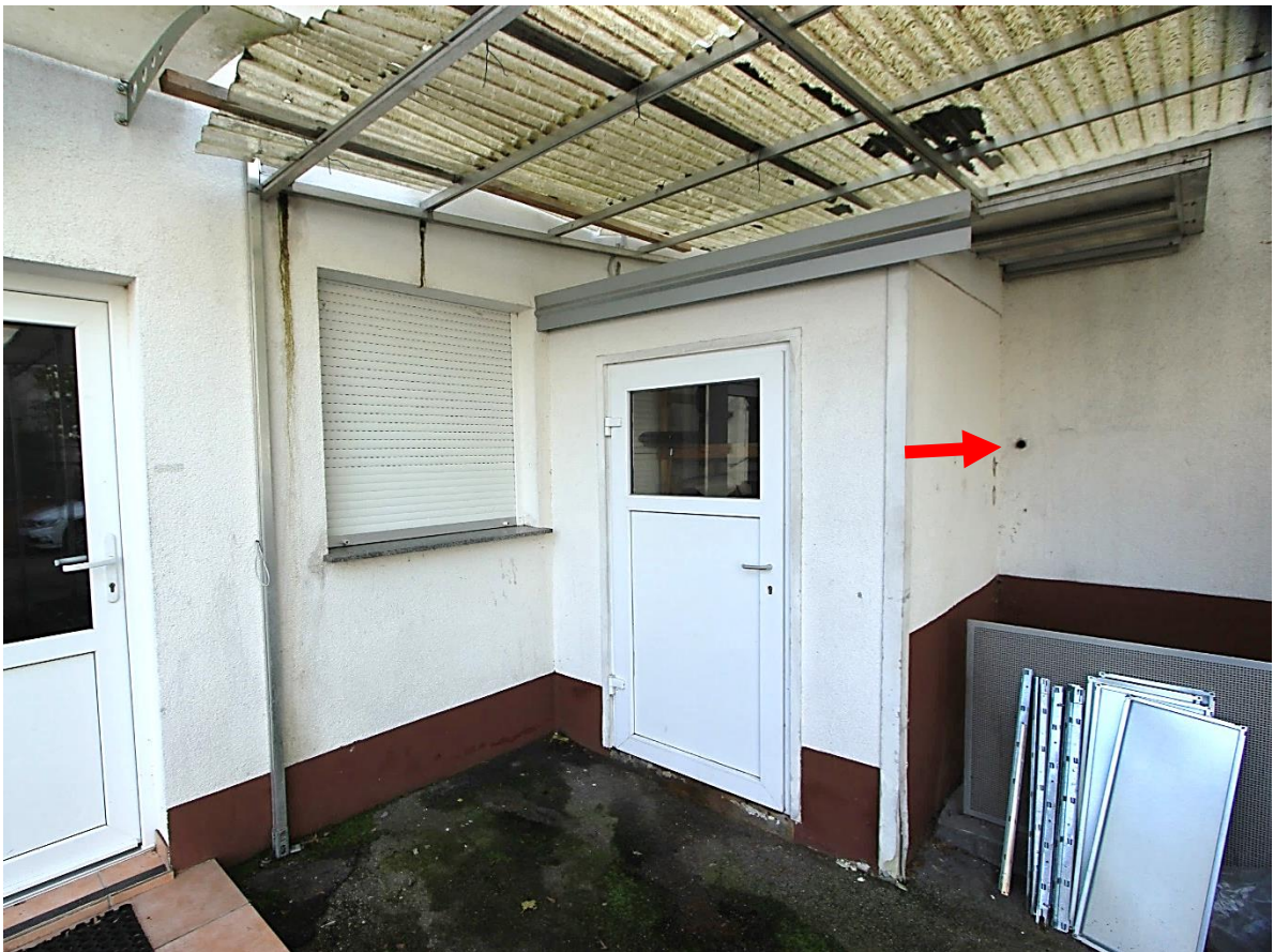
Anschluss Wohnhaus (Pfeil rechts) an den Nachbaranbau mit Wohnraumeinbau (links)
