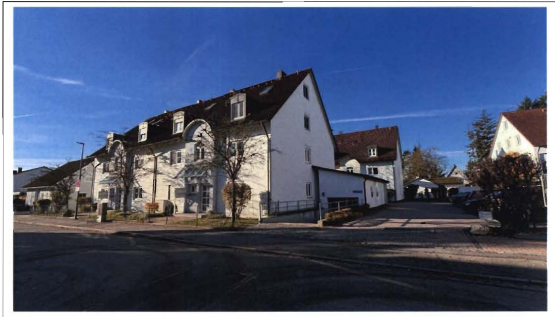
Foto 1: Wohnanlage - Ansicht von Nordosten
