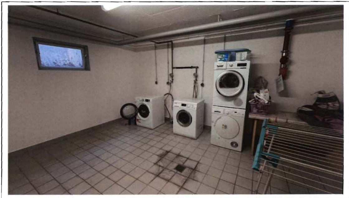
Foto 22: Blick in den Waschraum
