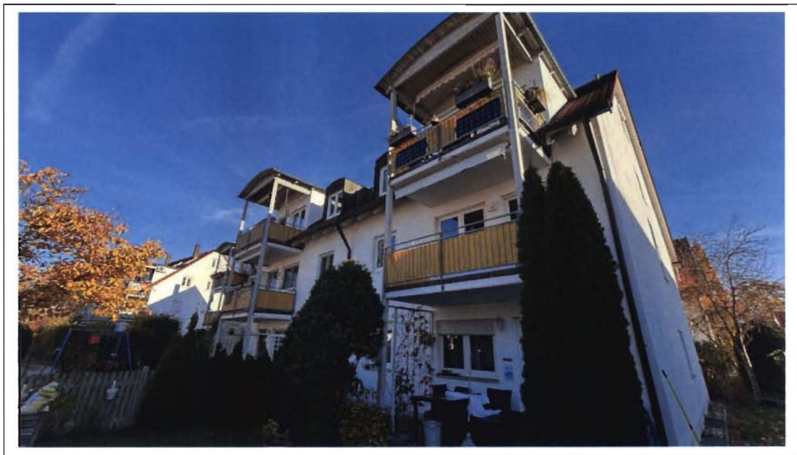
Foto 4: Haus Nr. 2D - Ansicht von Westen
