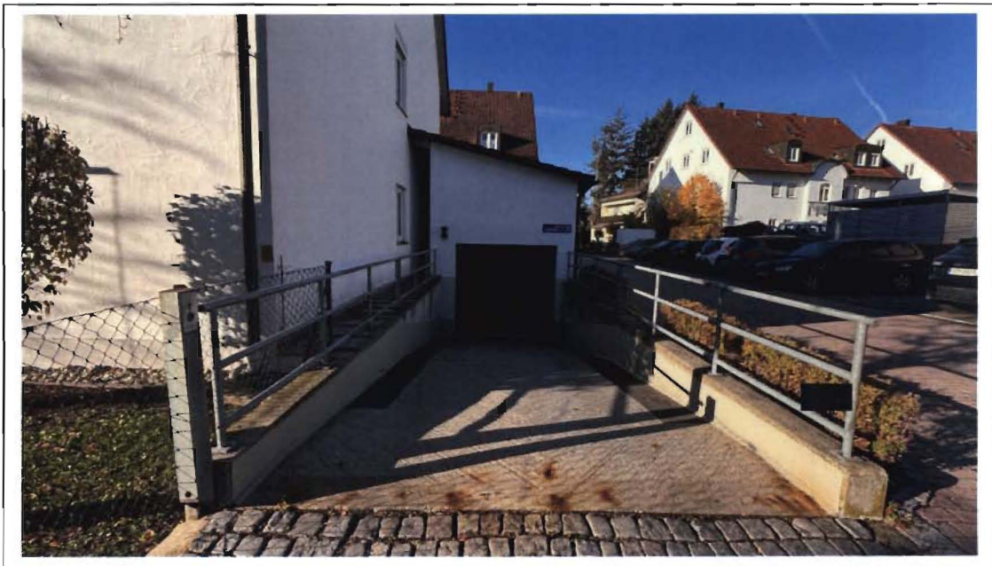
Foto 6: Zufahrt Tiefgarage - Ansicht von Osten
