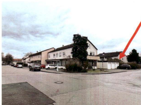
beispielhafte Ansicht der Südwestseite des Garagengebäudes
