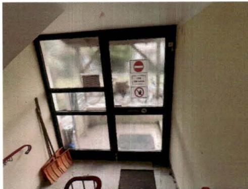
beispielhafte Ansicht des doppel­flügeligen Ein­gangs­element an der Gebäude-Ostseite
