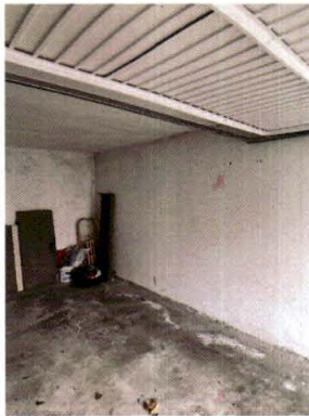
beispielhafte Ansicht des Bodenbelages
