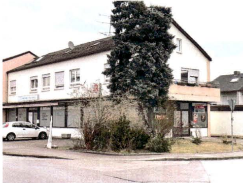
beispielhafte Ansicht der Südwestseite
