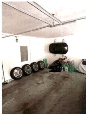
beispielhafte Ansicht der Deckenuntersicht im Garagegebäude
