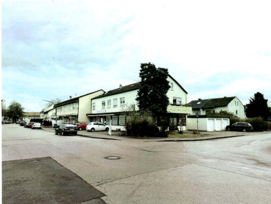
beispielhafte Ansicht der Südwestseite des Wohn- und Geschäftshauses mit Garagengebäude
