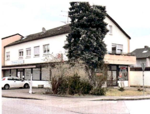
Westseite des Wohn- und Geschäftshauses
