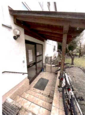
beispielhafte Ansicht der Zugangstreppe und des Eingangspodests an der Gebäude-Ostseite
