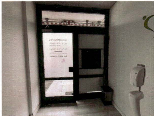
beispielhafte Ansicht des doppelflügeligen Eingangselements an der Gebäude-Westseite
