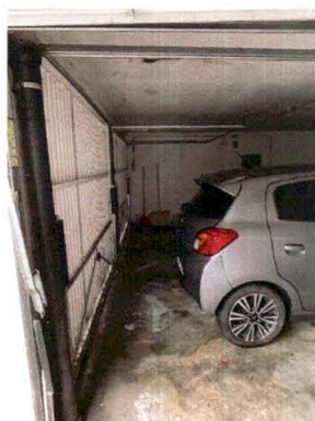
beispielhafte Teilansicht der Garagentore
