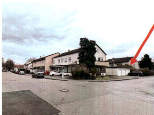
beispielhafte Ansicht der Südwestseite des Garagengebäudes
