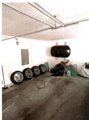
beispielhafte Ansicht der Deckenuntersicht im Garagegebäude
