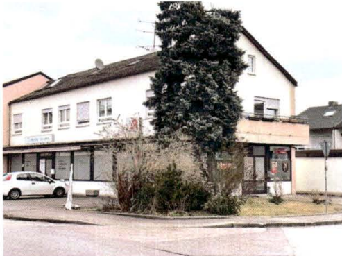
beispielhafte Ansicht der Gebäude-Südwestseite des Wohn- und Geschäftshauses – Liegnitzer Straße 18
