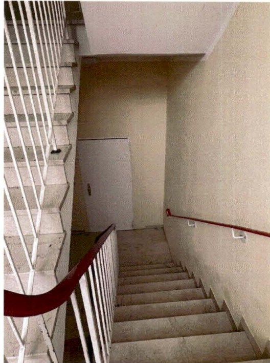
beispielhafte Ansicht des Treppenabgangs vom Erd- ins Kellergeschoss
