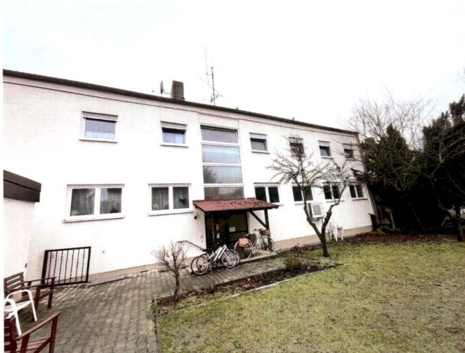
beispielhafte Ansicht der Ostseite des Wohn- und Geschäftshauses
