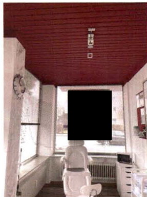
beispielhafte Ansicht der Holzdecke im Behandlungsbereich 1
