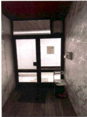
beispielhafte Ansicht der Eingangstüre zur Wohnung Nr. 2
