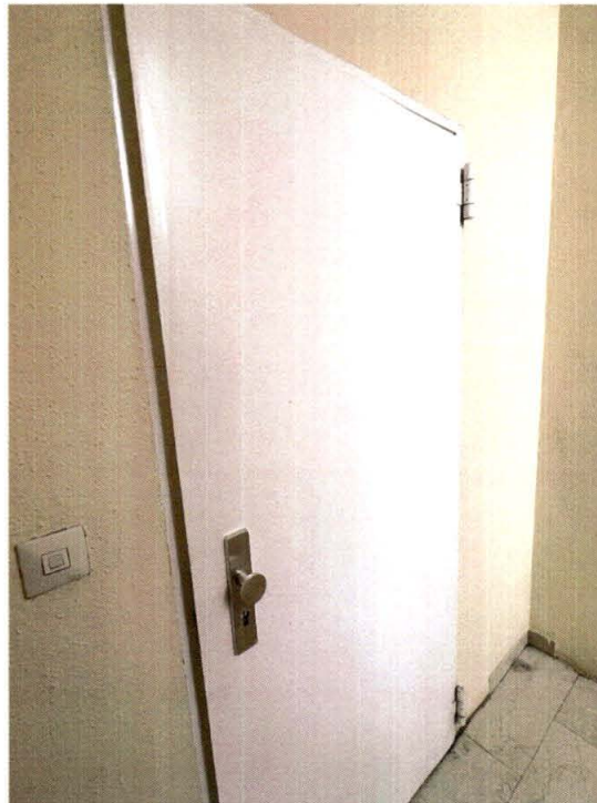
beispielhafte Ansicht der Türe vom Treppenhaus zur Gewerbeeinheit Nr. 1
