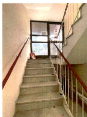
beispielhafte Ansicht der Geschosstreppe zwischen Keller- und Erdgeschoss
