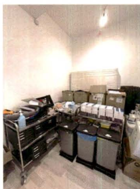
beispielhafte Ansicht der Decke im „Personal- raum“
