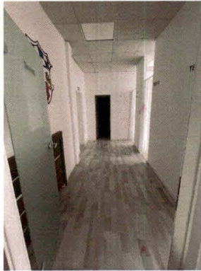
beispielhafte Ansicht des Bodenbelags im Erschließungsflur
