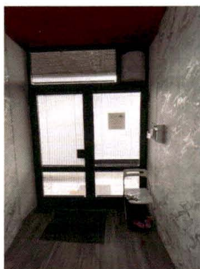
beispielhafte Ansicht des doppelflügeligen Eingangselements an der Gebäude-Südseite
