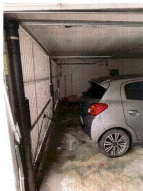
beispielhafte Teilansicht der Garagentore
