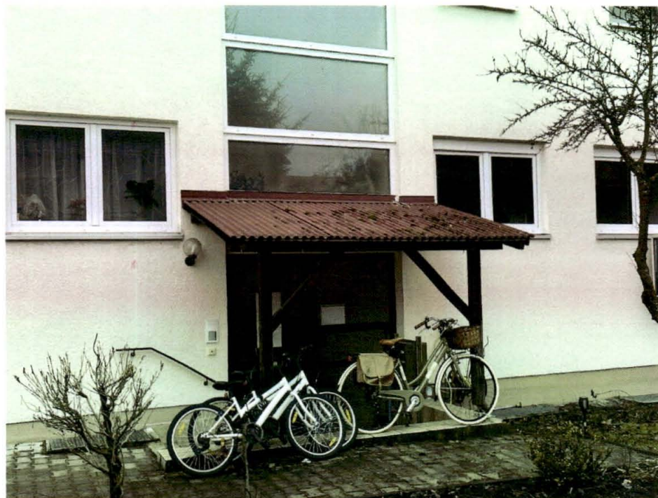
beispielhafte Ansicht des Eingangsbereiches mit Zugangstreppe nach unten
