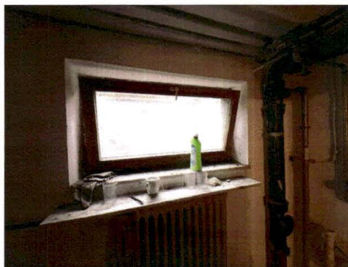
beispielhafte Ansicht des Fensters in der Waschküche des Kellergeschosses
