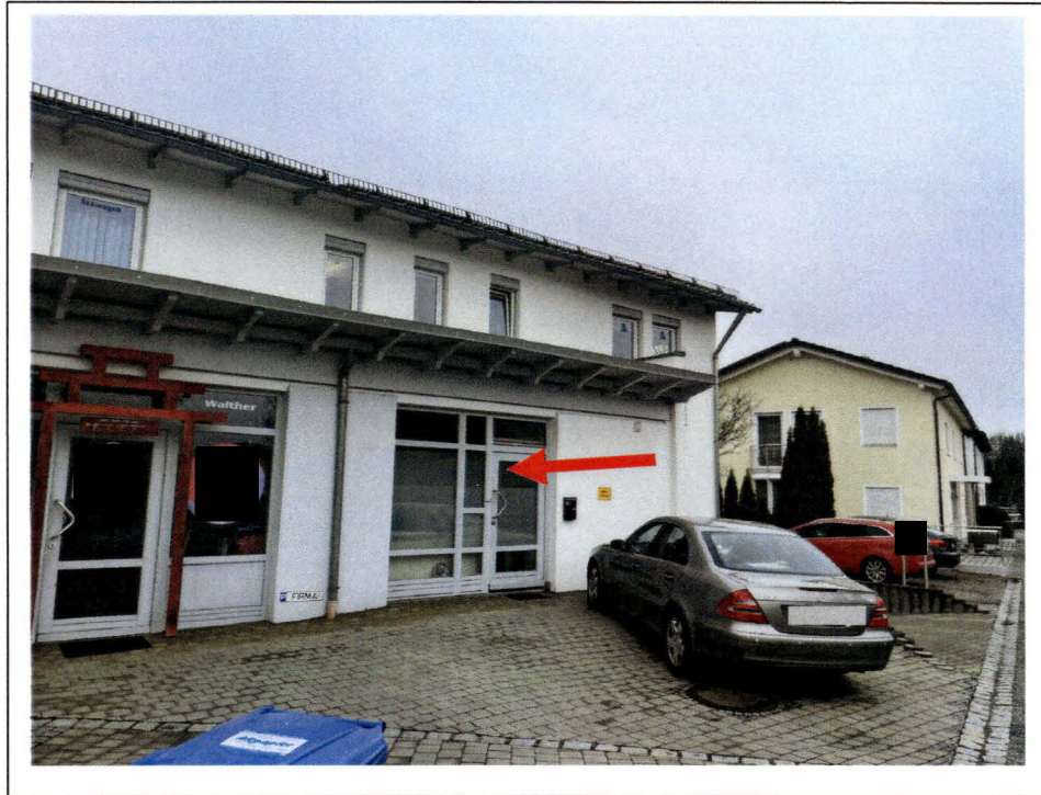
Foto 1: Ansicht von Osten
