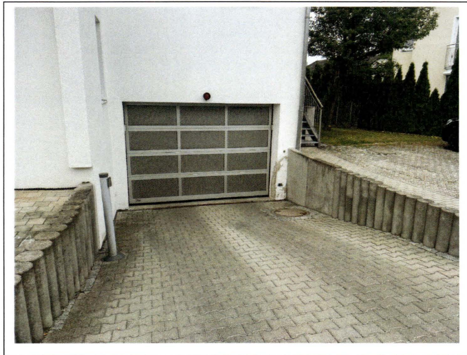
Foto 7: Tiefgaragenzufahrt - Ansicht von Osten
