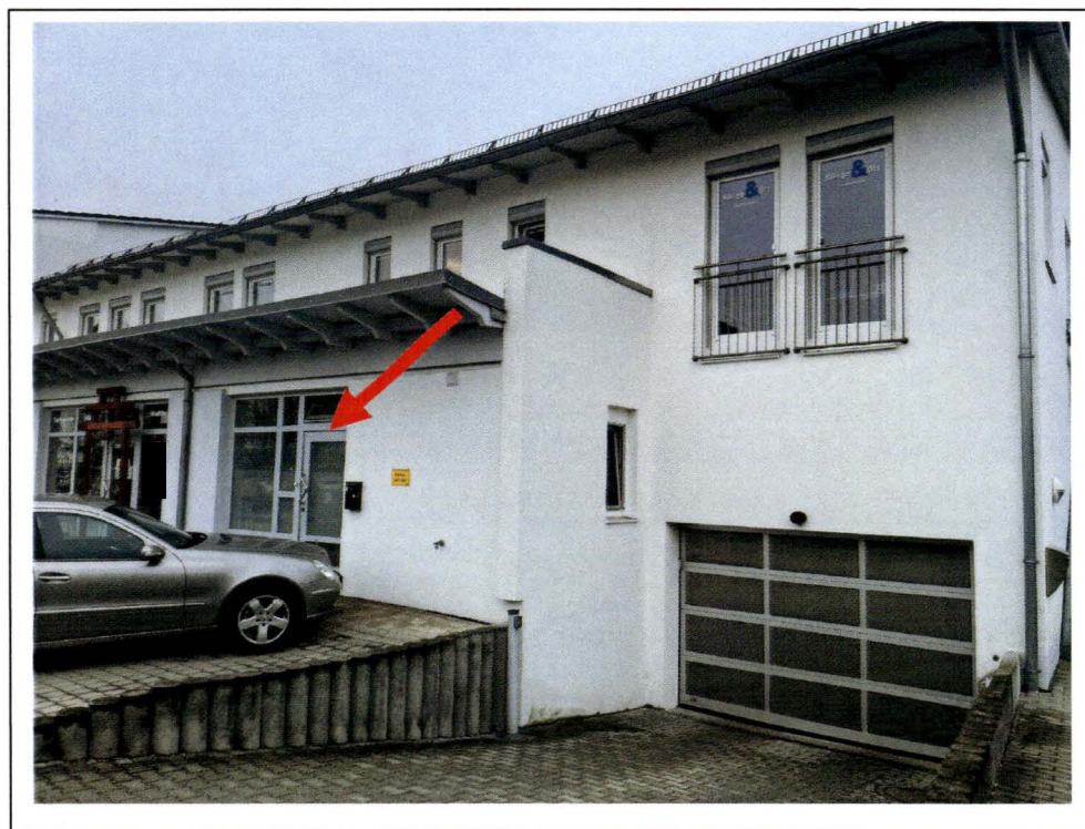
Foto 2: Ansicht von Nordosten
