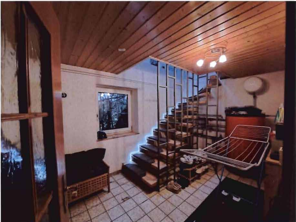
16 Wohnung Nr. 1 EG, Treppenhaus und Haustechnik
