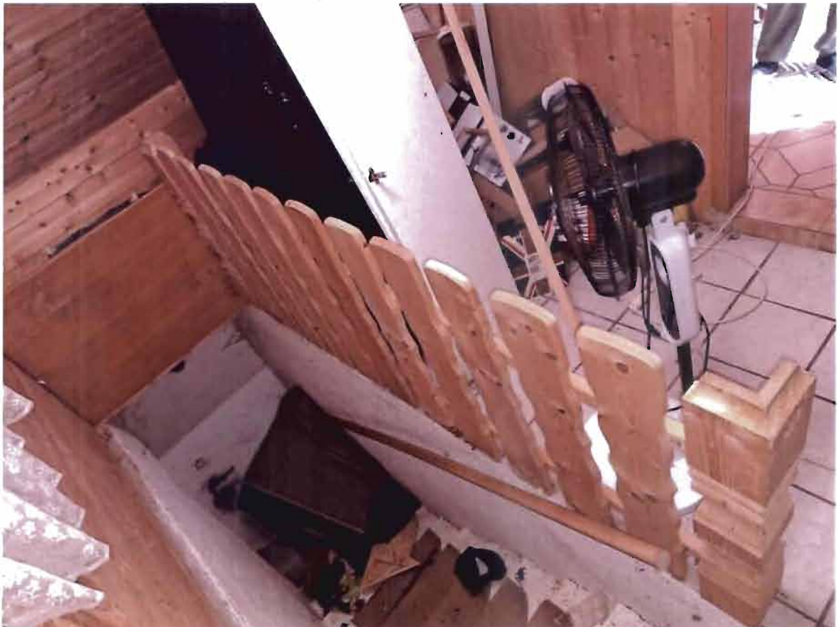
26 2. Zugang zur Wohnung Nr. 2 über Garage
