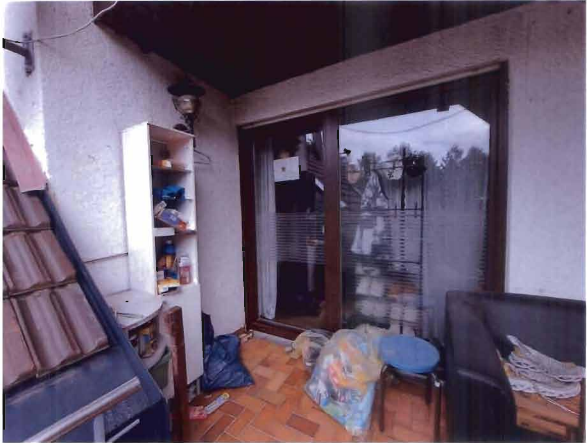
25 Hauptzugang Wohnung Nr. 2 über Balkon
