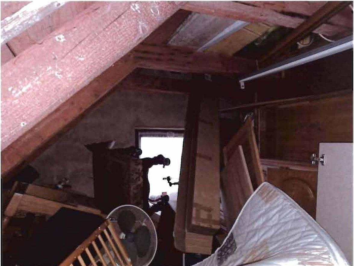
32 Lagerraum über der Garage
