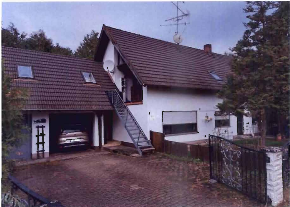
1 Außenansicht Südwest und Südost
