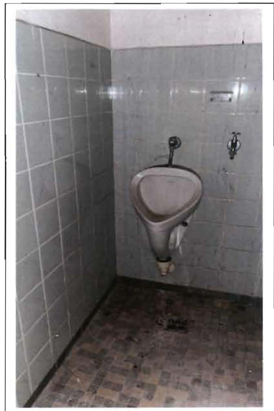
Foto 15: Sanitäre Anlagen im EG
