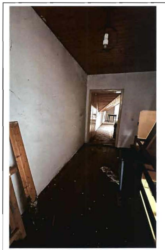
Foto 19: Flur im Dachgeschoss
