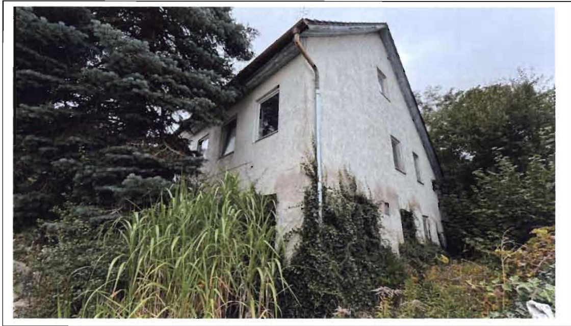
Foto 3: Ansicht von Südosten
