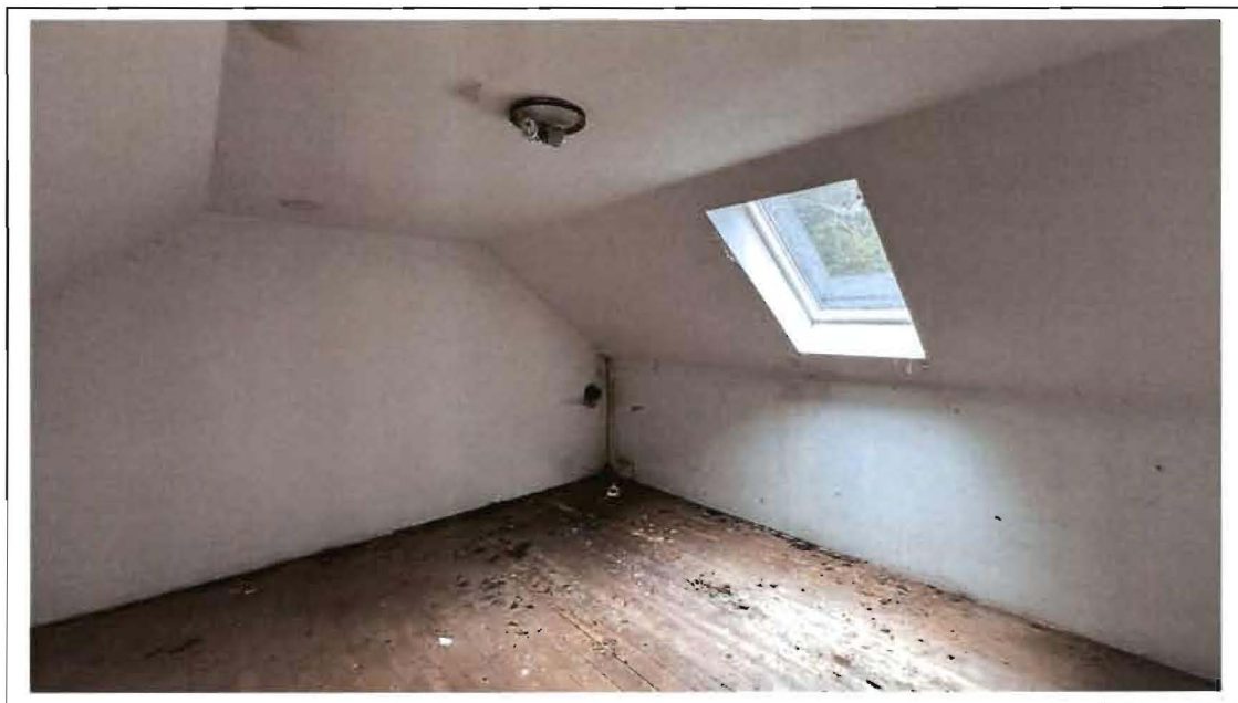
Foto 24: Blick in einen DG-Raum im Anbau 2
