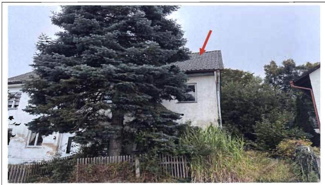
Foto 2: Ansicht von Süden
