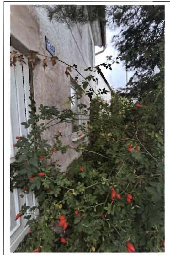
Foto 9: südliche Fassade, Vorgarten
