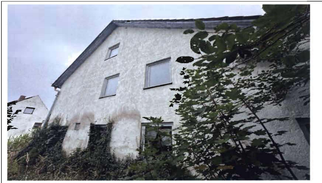
Foto 4: Ansicht von Nordosten
