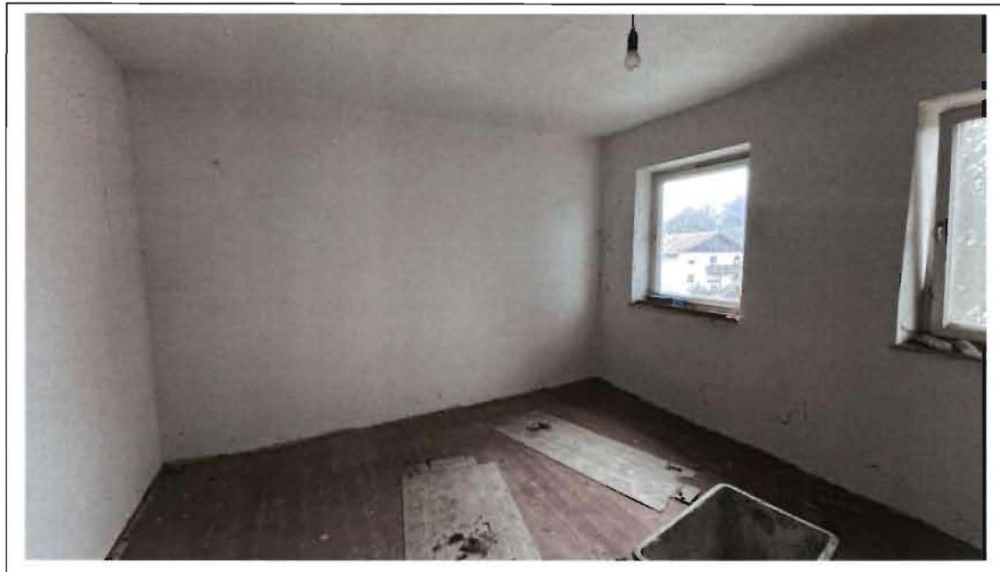
Foto 20: Blick in einen OG-Raum
