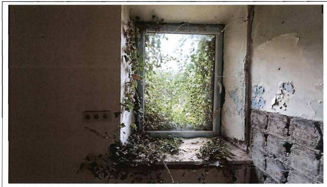
Foto 17: Blick zum Fenster
