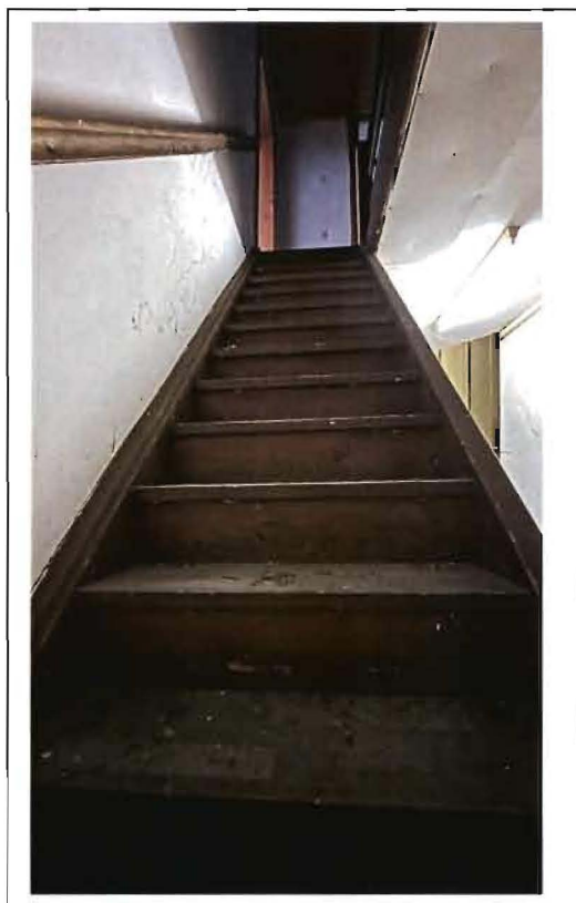
Foto 18: Treppe zum Dachgeschoss
