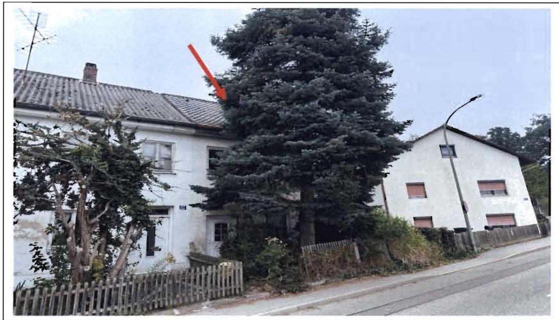
Foto 1: Ansicht von Südwesten
