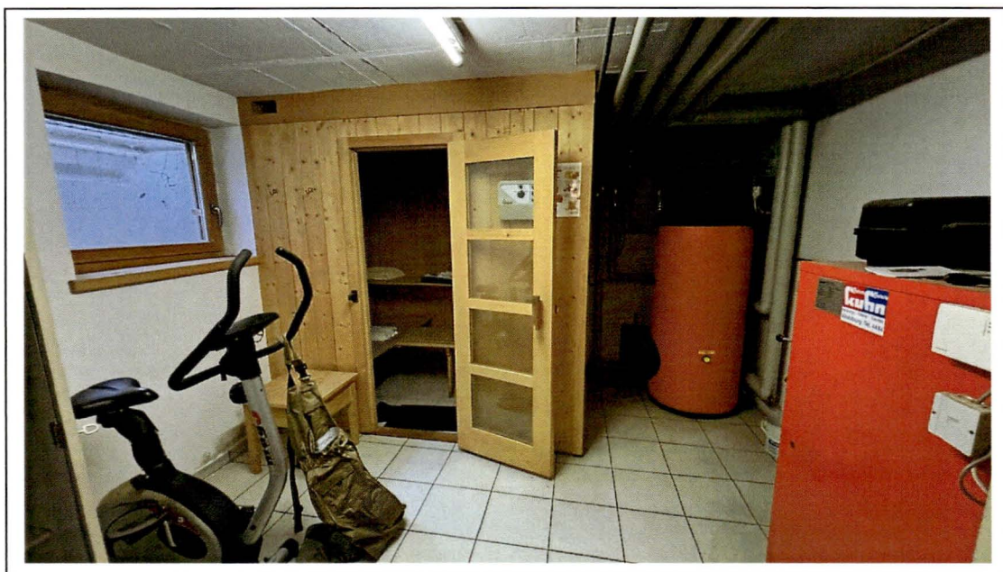
Foto 32: ursprünglicher Heizungskeller mit Sauna / Keller-Anbau
