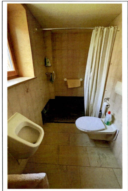
Foto 13: Blick in das Dusch WC / Altbau
