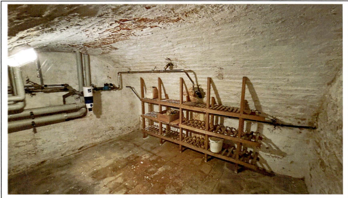
Foto 33: alter Gewölbekeller im Altbau
