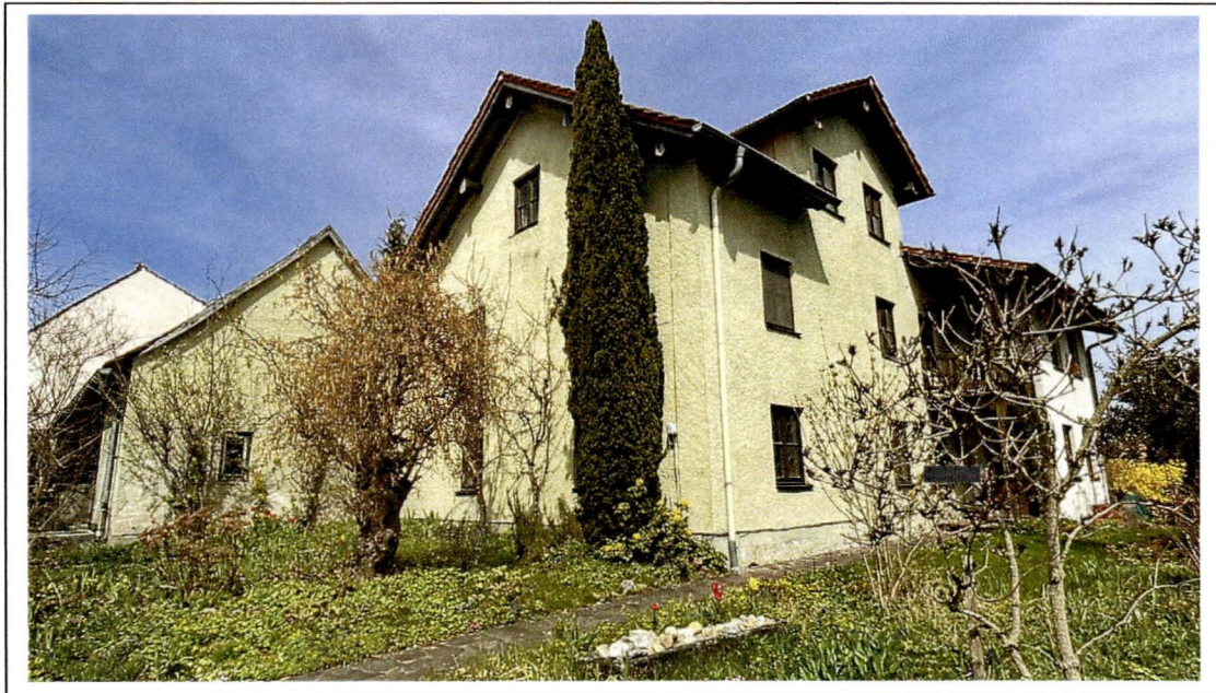
Foto 1: Ansicht von Südosten
