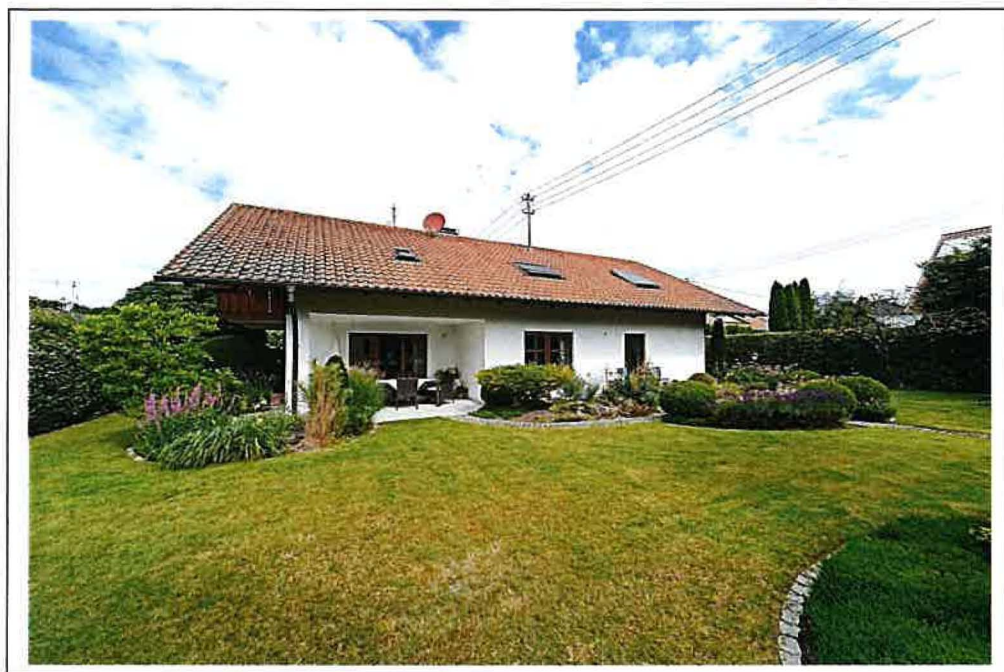
Foto 1: Illertissen, Veilchenweg 5; Ansicht Südwest (Stand 17.07.2024)
