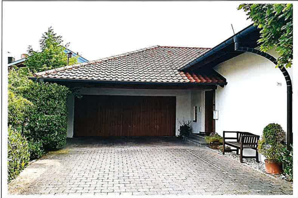
Foto 7: Illertissen, Veilchenweg 5; Ansicht Garage (Stand 20.06.2024)
