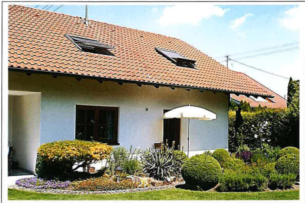
Foto 5: Illertissen, Veilchenweg 5; Ansicht Südwest (Stand 18.06.2019)
