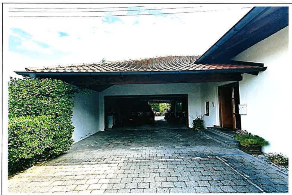
Foto 2: Illertissen, Veilchenweg 5; Ansicht Garage (Stand 17.07.2024)
