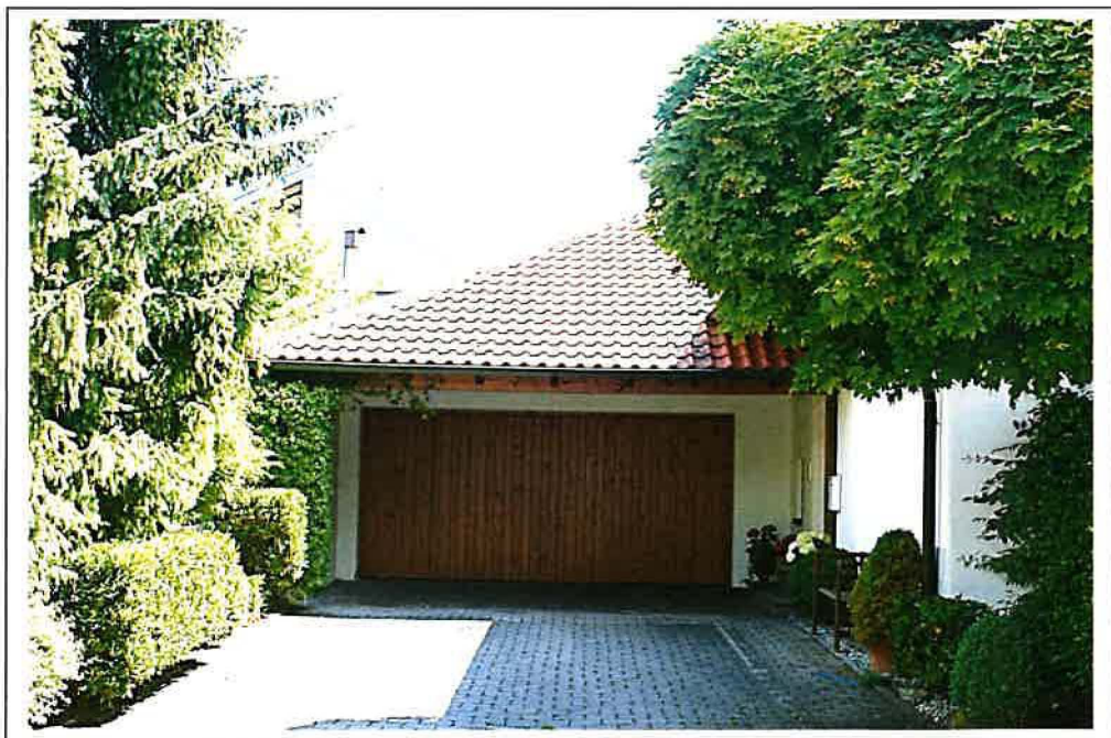
Foto 8: Illertissen, Veilchenweg 5; Ansicht Garage (Stand 18.06.2019)
