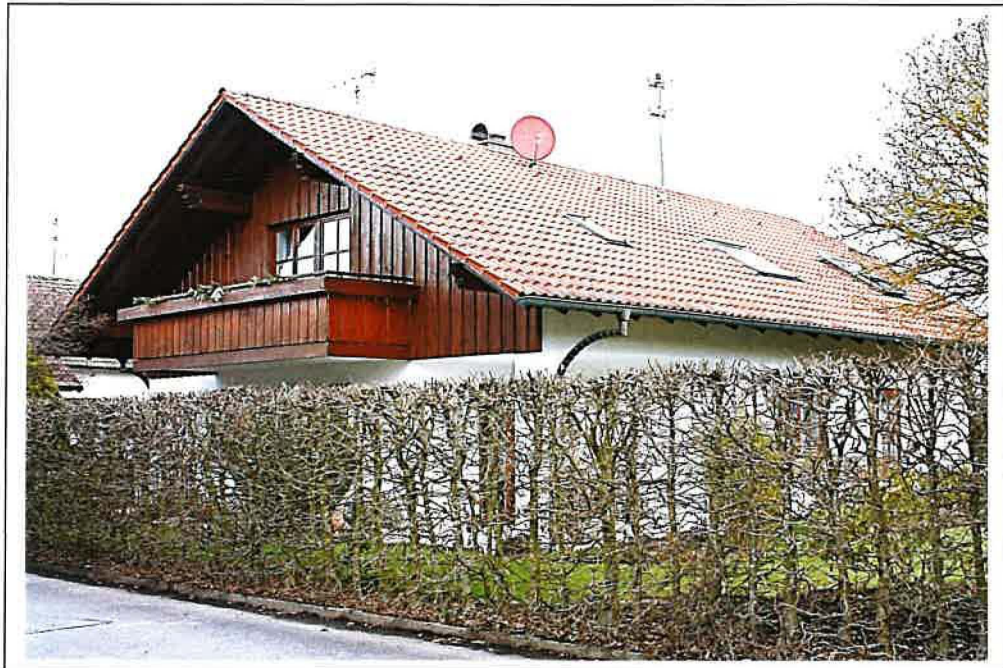
Foto 1: Illertissen, Veilchenweg 5; Ansicht Südwest (Stand 18.06.2019)
