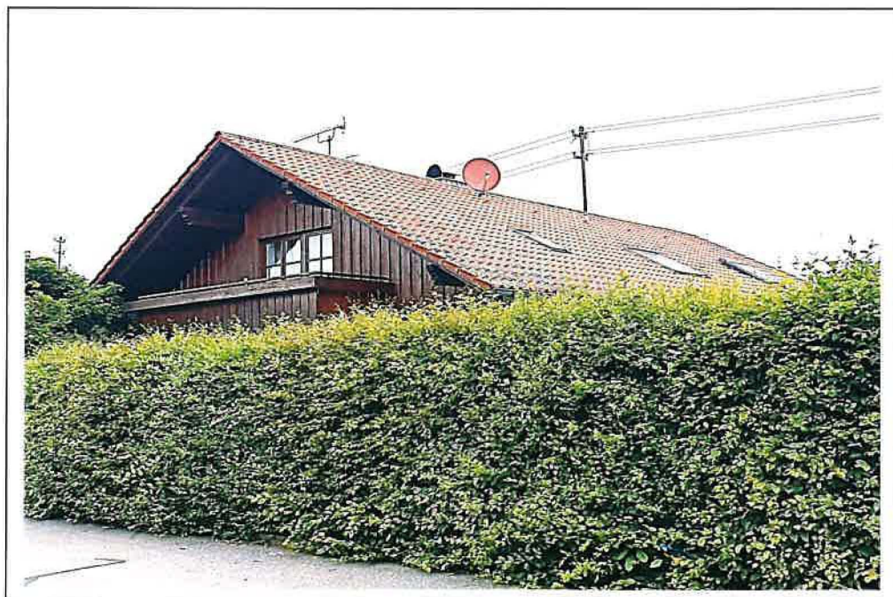
Foto 2: Illertissen, Veilchenweg 5; Ansicht Südwest (Stand 20.06.2024)
